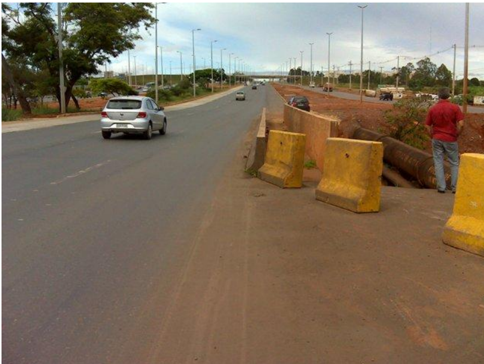
Estreitamento de via e falta de sinalização.
