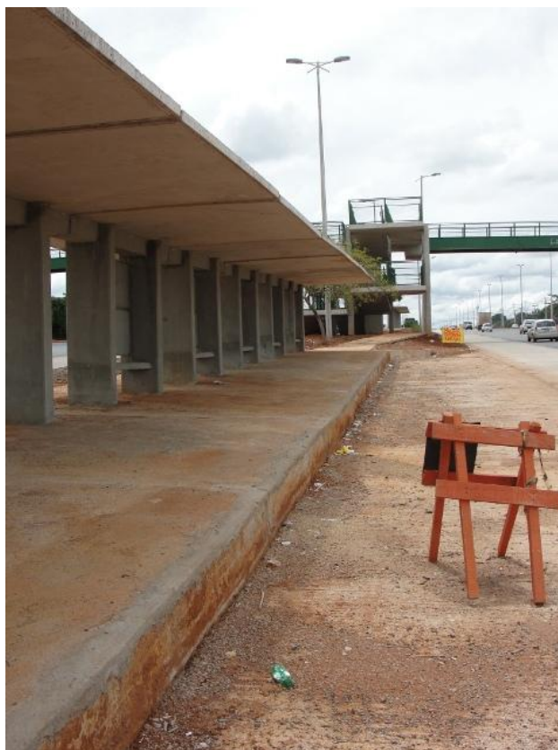
Construção dos pontos: base de estrutura pré-fabricada, sem nenhum acabamento.
