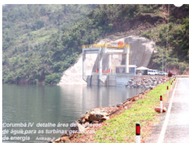
Foto 17 – Ponto de tomada d'água
