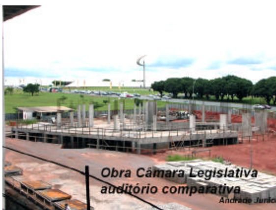
Foto 5 – Obras da fundação do plenário e de auditórios
