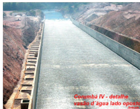
Foto 16 – Vertedouro – lado oposto
