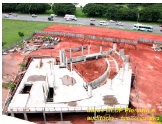
Foto 6 – Obras da fundação do plenário e de auditórios
