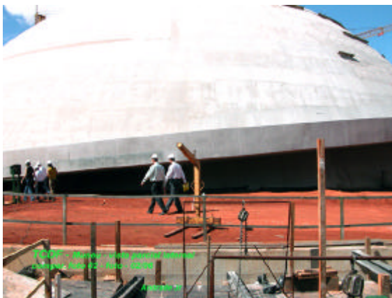
Foto 9 – Vista parcial das obras do Museu
