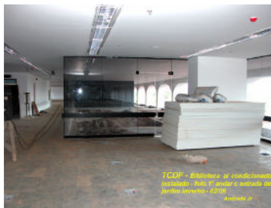
Foto 7 – Instalação da tubulação de ar condicionado
