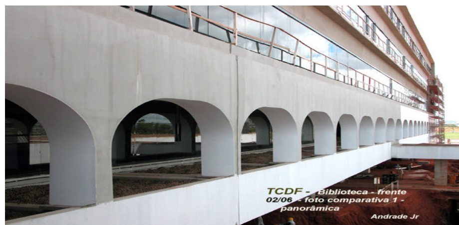
Foto 5 – Vista panorâmica da construção da Biblioteca
