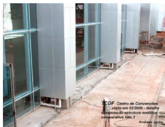
Foto 2 – Sustentação das estruturas metálicas
