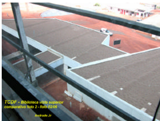
Foto 6 – Construção da Biblioteca
