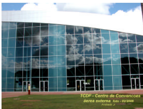
Foto 1 – Colocação dos vidros externos
