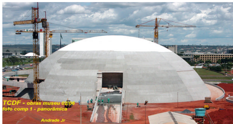
Foto 8 – Vista panorâmica do canteiro de obras do Museu
