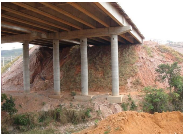
Foto 3 – Sustentação do Viaduto
