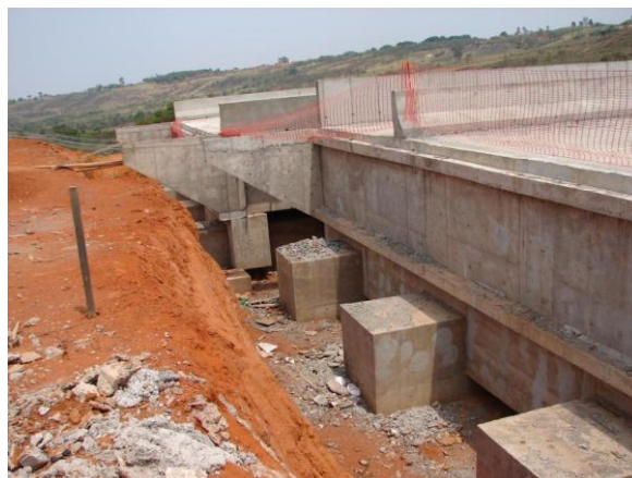
Foto 4 – Cabeceira do Viaduto
