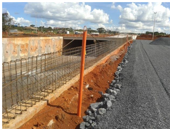
Execução de base de brita e parede do túnel
