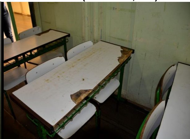
Foto 4 – Sala de Aula
