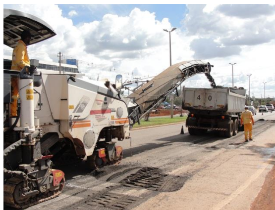
Fresagem de pavimento na EPAR
