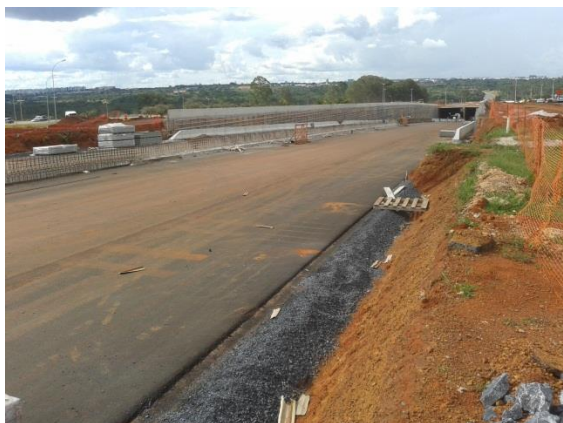
Via principal da EPAR com entrada do túnel ao fundo
