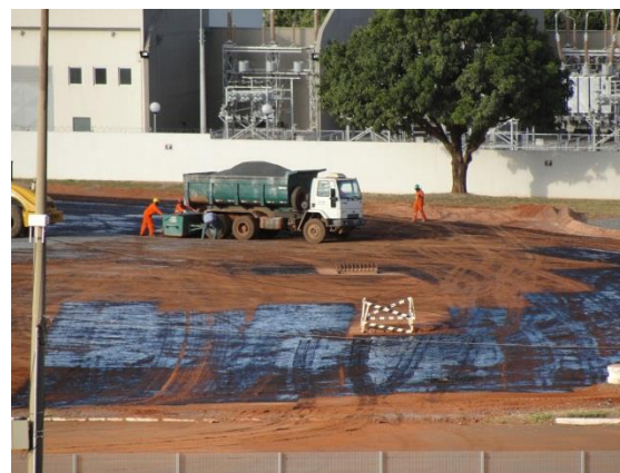
Área externa em obras
