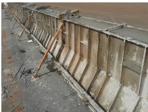
Concretagem de guarda-corpo
