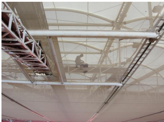
Detalhe da cobertura
