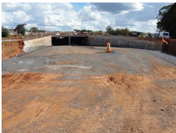
Execução de vias de acesso ao túnel
