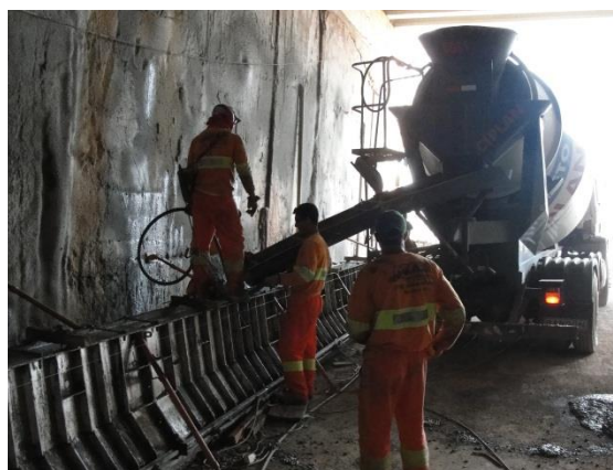
Concretagem no interior do túnel
