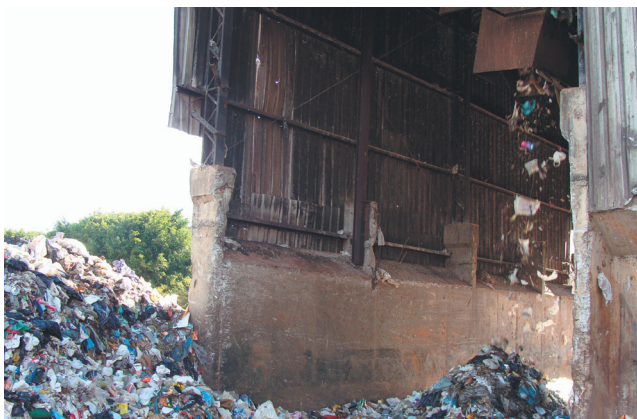
Imagem 6: Rejeitos no Nousel
