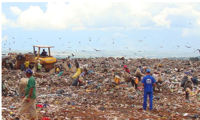
Imagem 15: Vasta área de RSU depositados sem cobertura, um trator de esteira espalhando e compactando os resíduos, grande quantidade de catadores e de aves no local.
