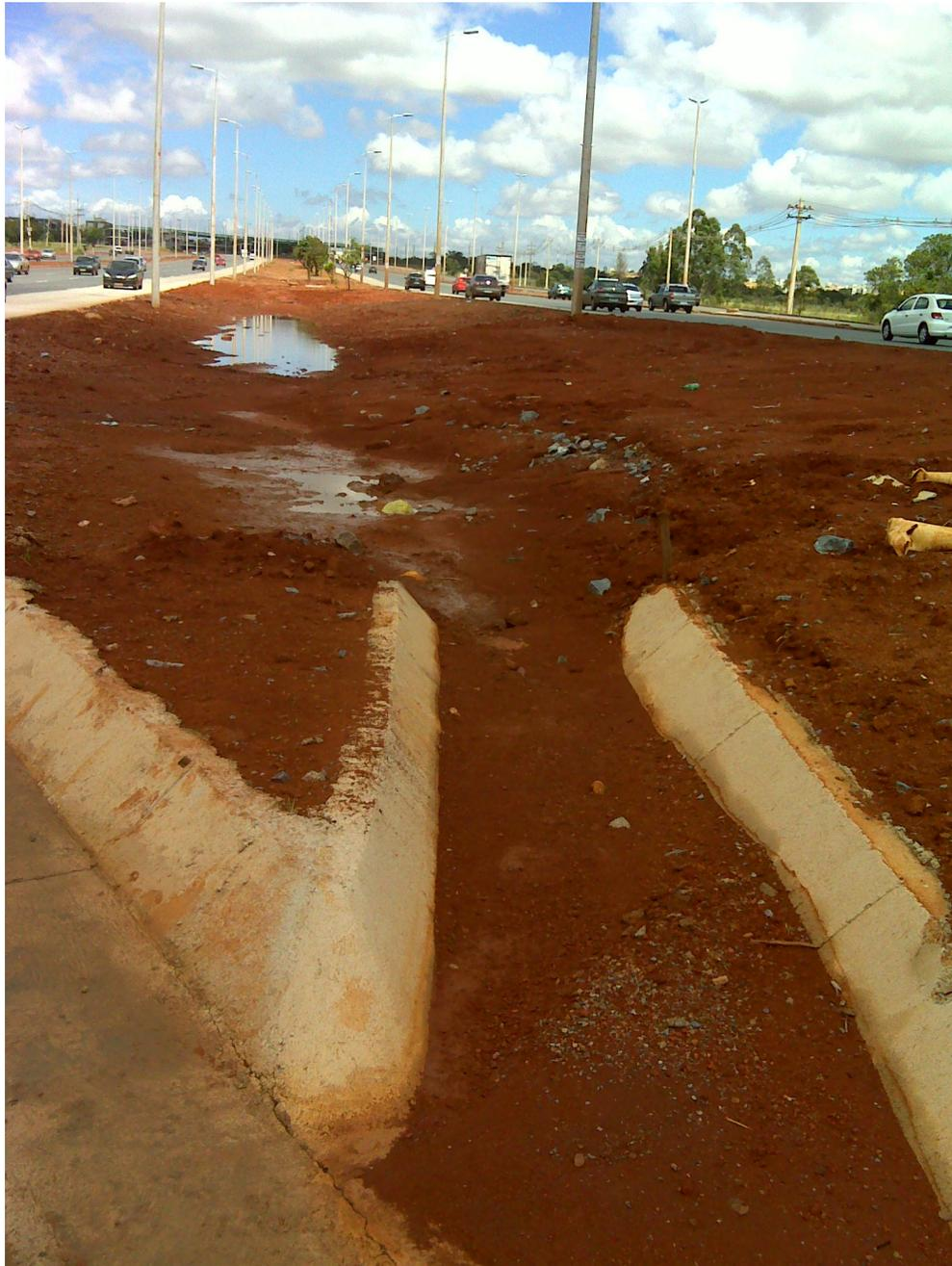
Fig. - Canaleta de drenagem incompleta
