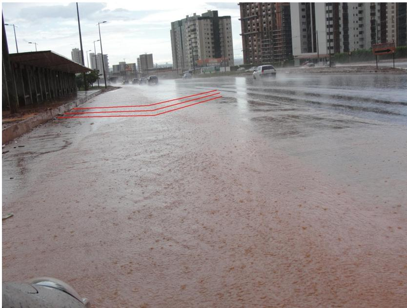
Figura 01 – Calha de escoamento de águas pluviais em frente à baia de ônibus.
