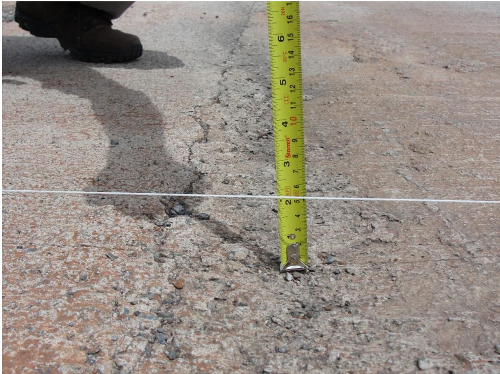
Fig. – Calha com 5 cm de altura entre pavimento rígido da via exclusiva e da baía de ônibus
