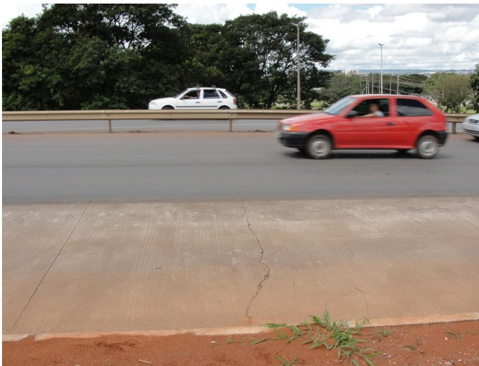
Fig. - Placa quebrada (trinca transversal)
