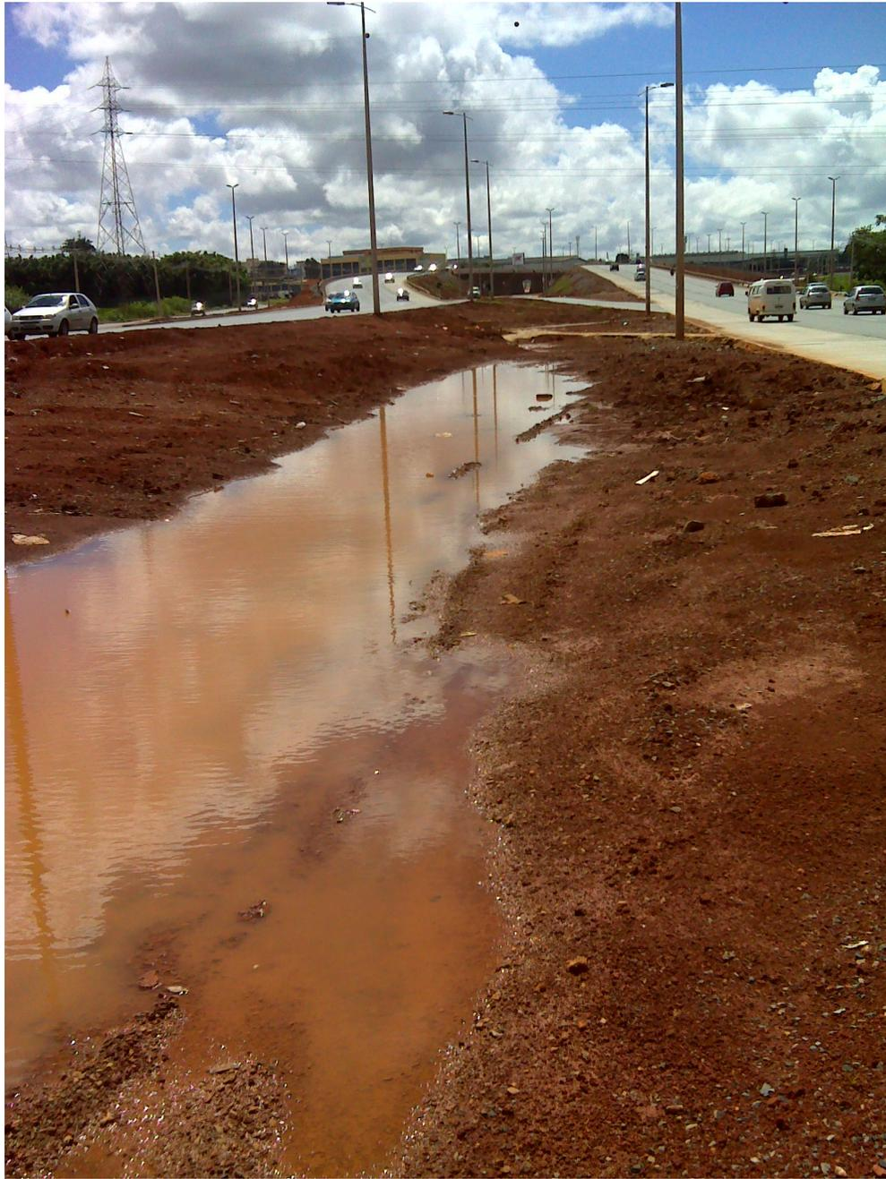
Fig. - Inexistência de canaleta de drenagem no canteiro central
