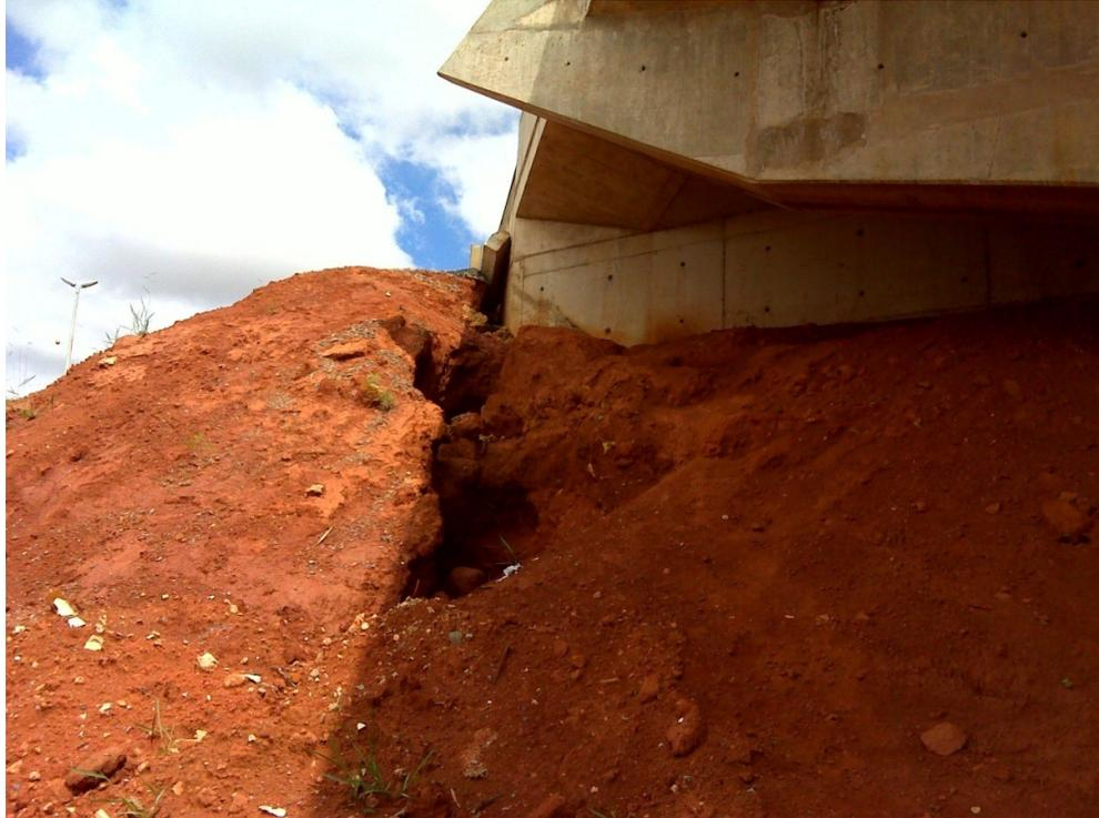
Fig. - Erosão no aterro de encabeçamento de viaduto
