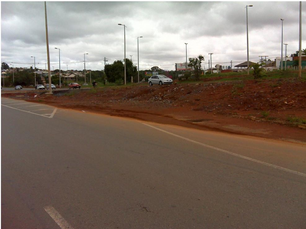
Fig. – Ausência de meio-fio
