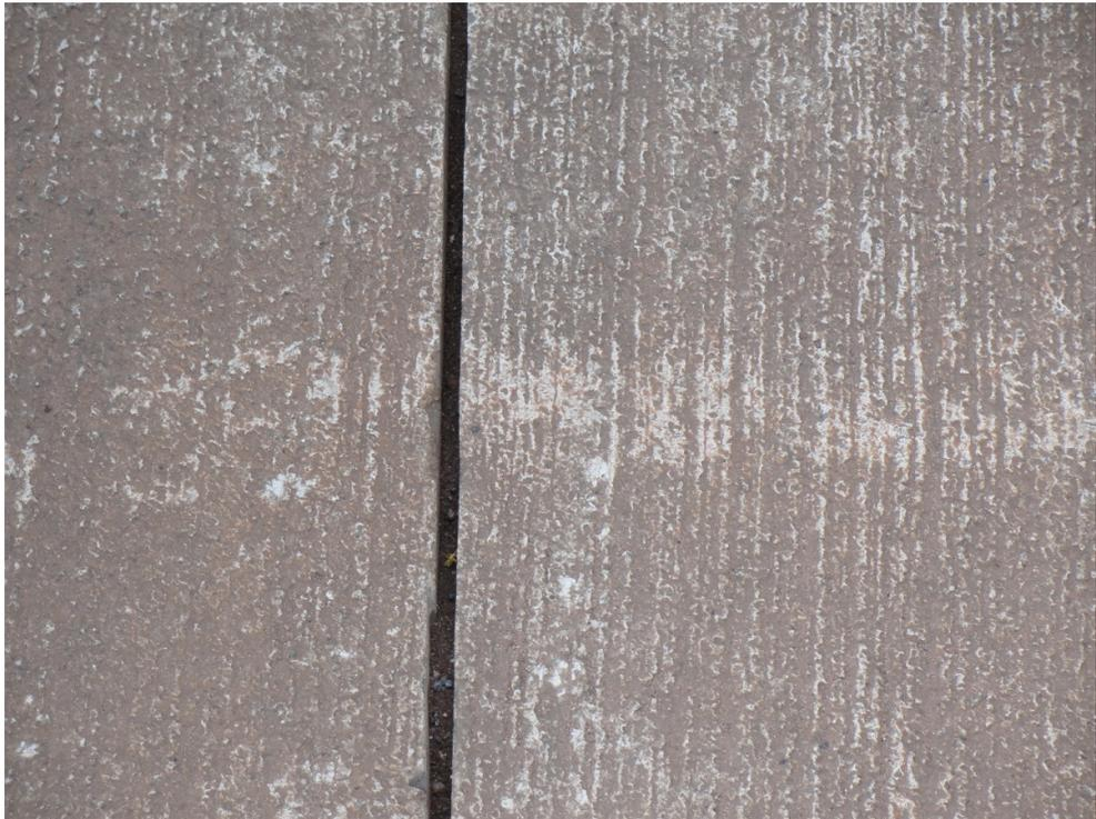
Fig. – Ausência de selagem das juntas
