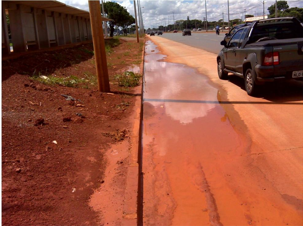
Fig. – Ausência de elemento de drenagem (saída de água) na via exclusiva de ônibus
