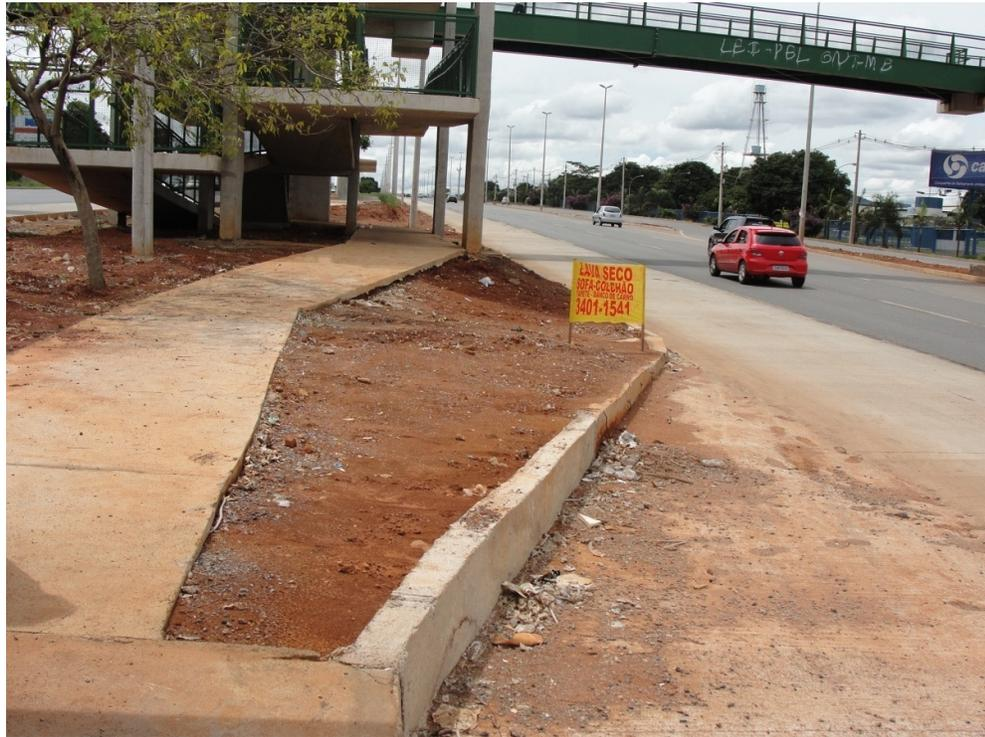
Fig. - Ausência de plantio de grama provoca erosão na base dos passeios
