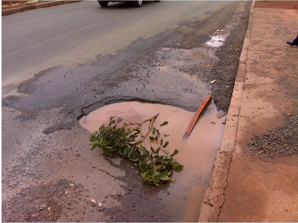
Fig. – Panela no acostamento
