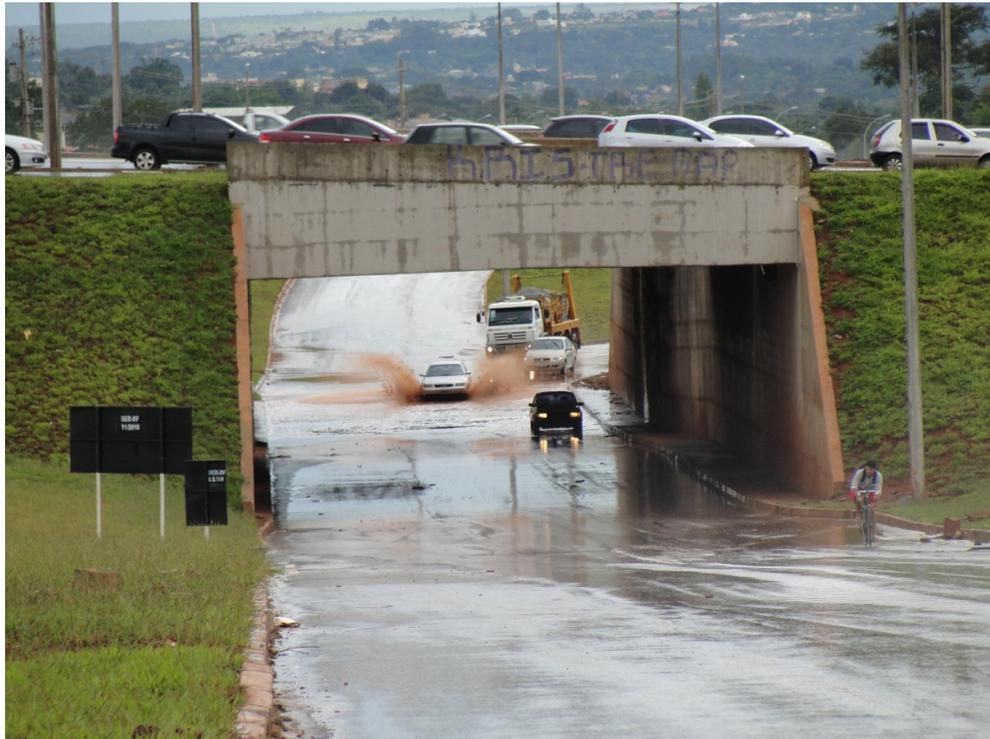
Fig. - Inexistência de drenagem pluvial na Trincheira da EPVL
