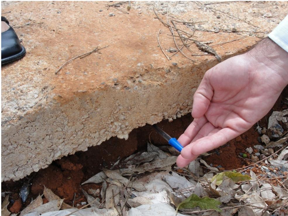
Fig. - Detalhe de erosão na base do passeio
