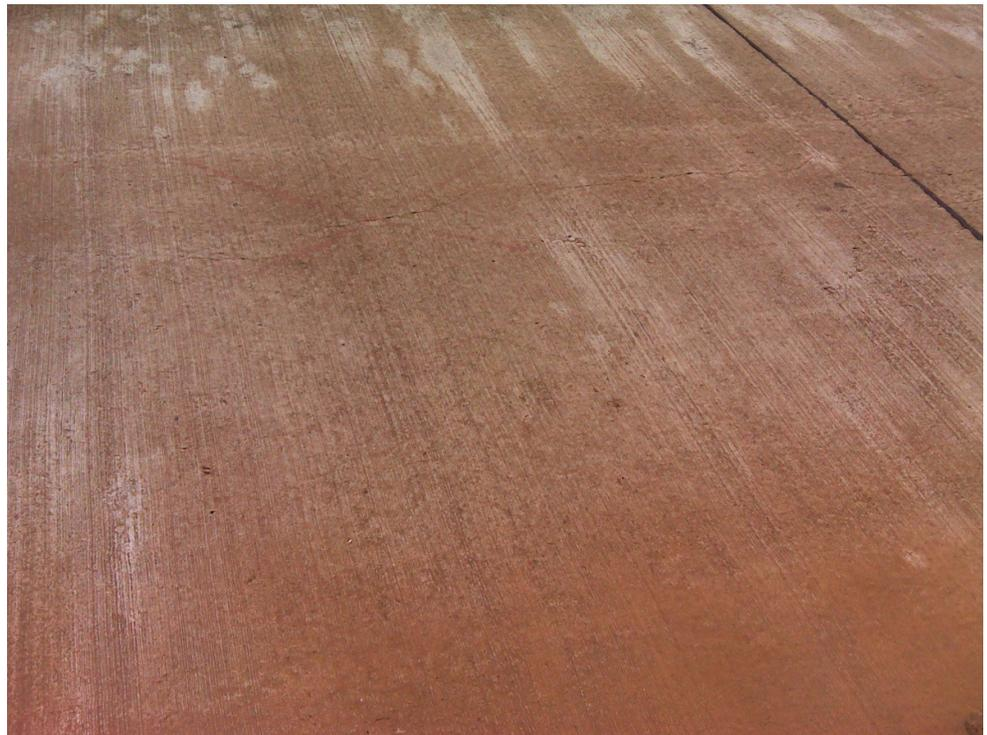
Fig. – Trinca longitudinal
