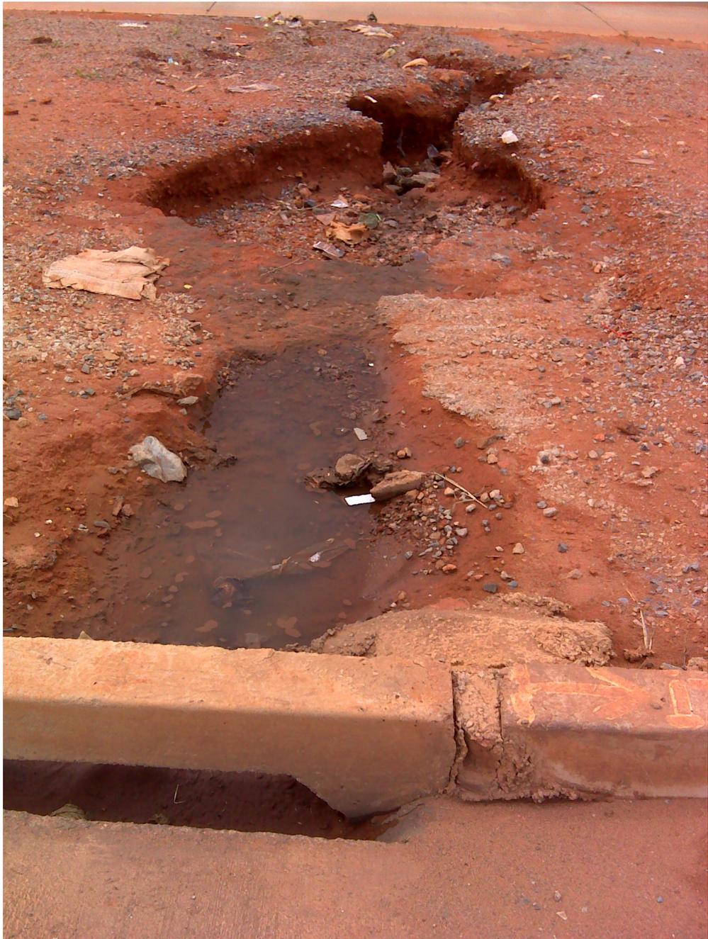
Fig. - Boca de lobo improvisada e ausência de calha
