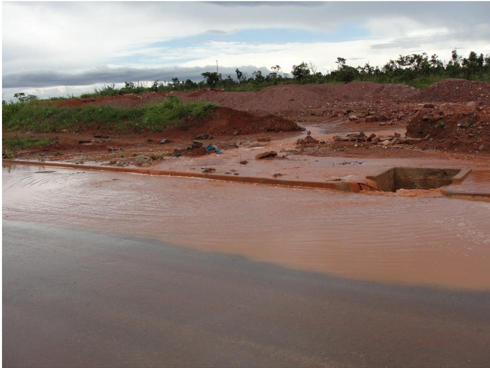
Fig. - Elemento de drenagem sem fechamento de proteção
