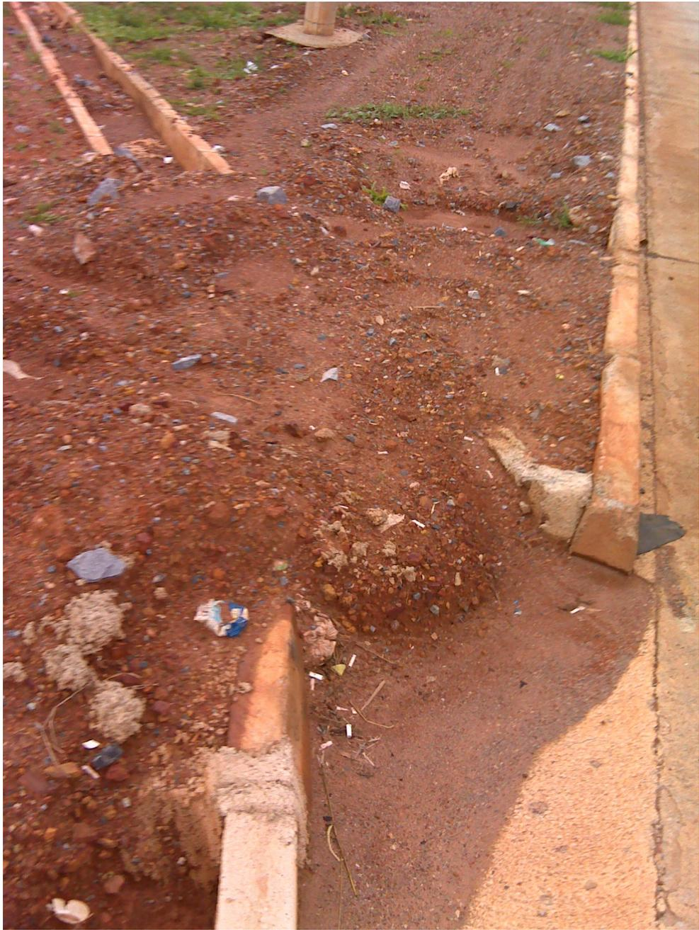
Fig. - Saída de água obstruída pelo carreamento de material decorrente da falta de plantio de grama
