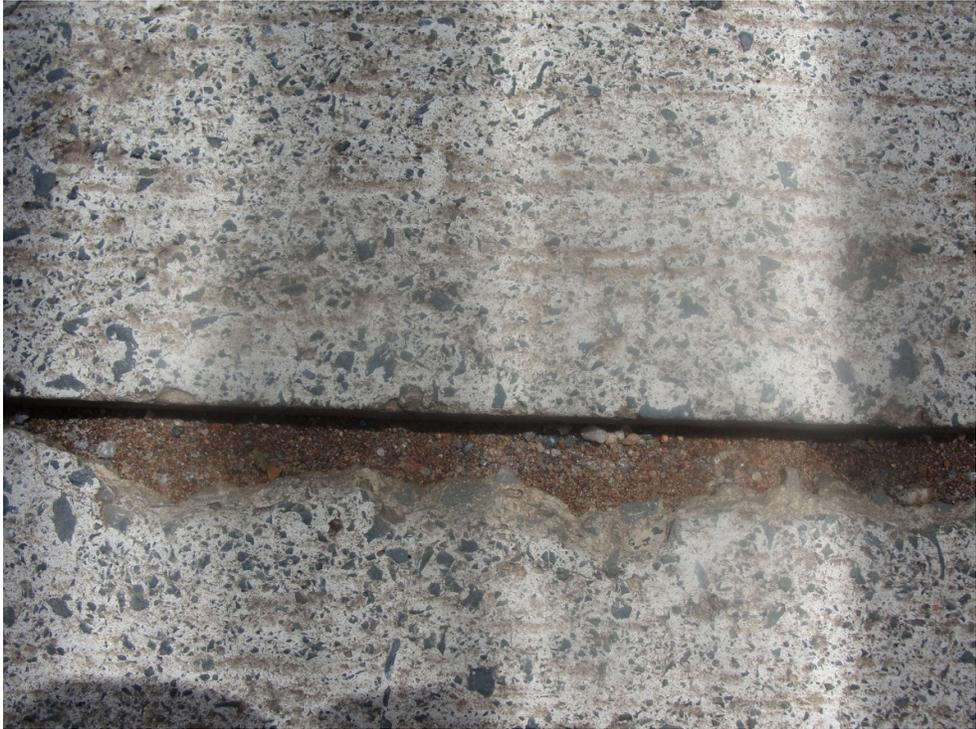
Fig. – Detalhe de esborcinamento de junta
