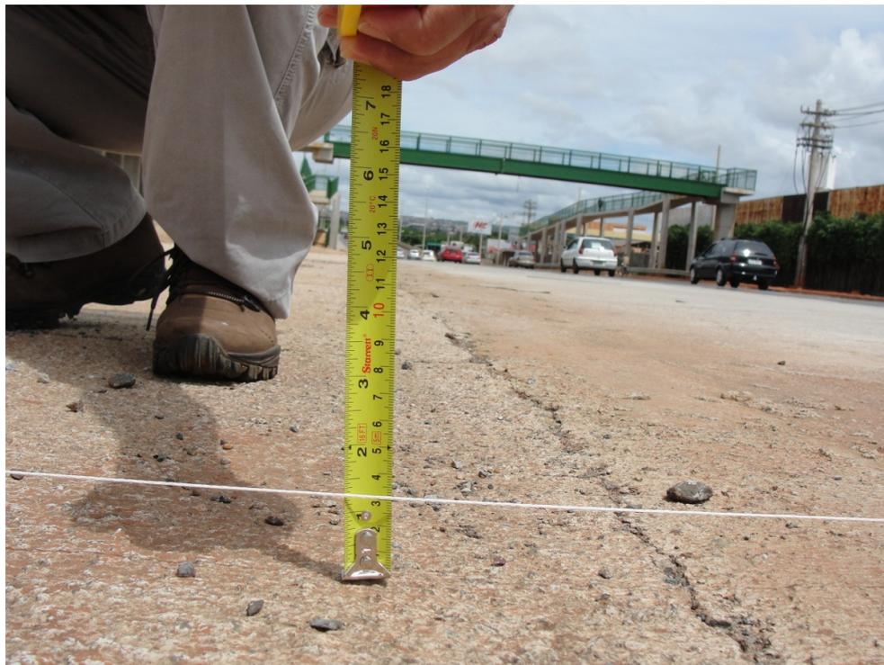
Fig. – Calha com 3 cm de altura entre pavimento rígido da via exclusiva e da baía de ônibus
