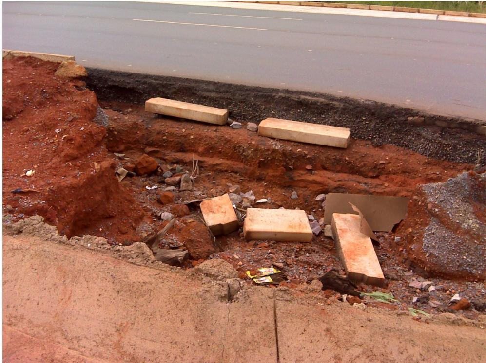
Fig. - Meios-fios demolidos por erosão
