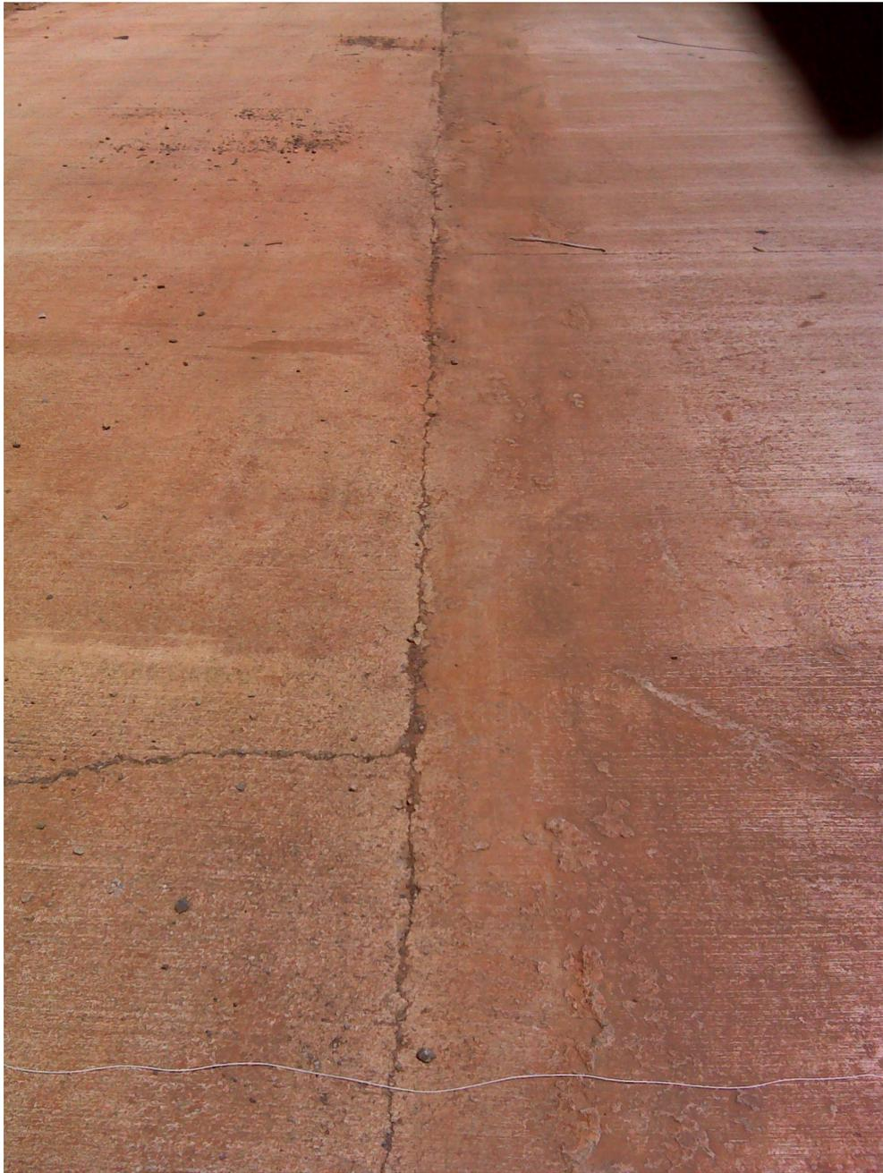
Fig. – Detalhe da inexistência de junta de dilatação longitudinal entre o pavimento rígido da via exclusiva e da baia de ônibus
