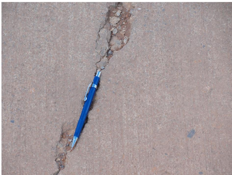
Fig. - Detalhe da placa quebrada
