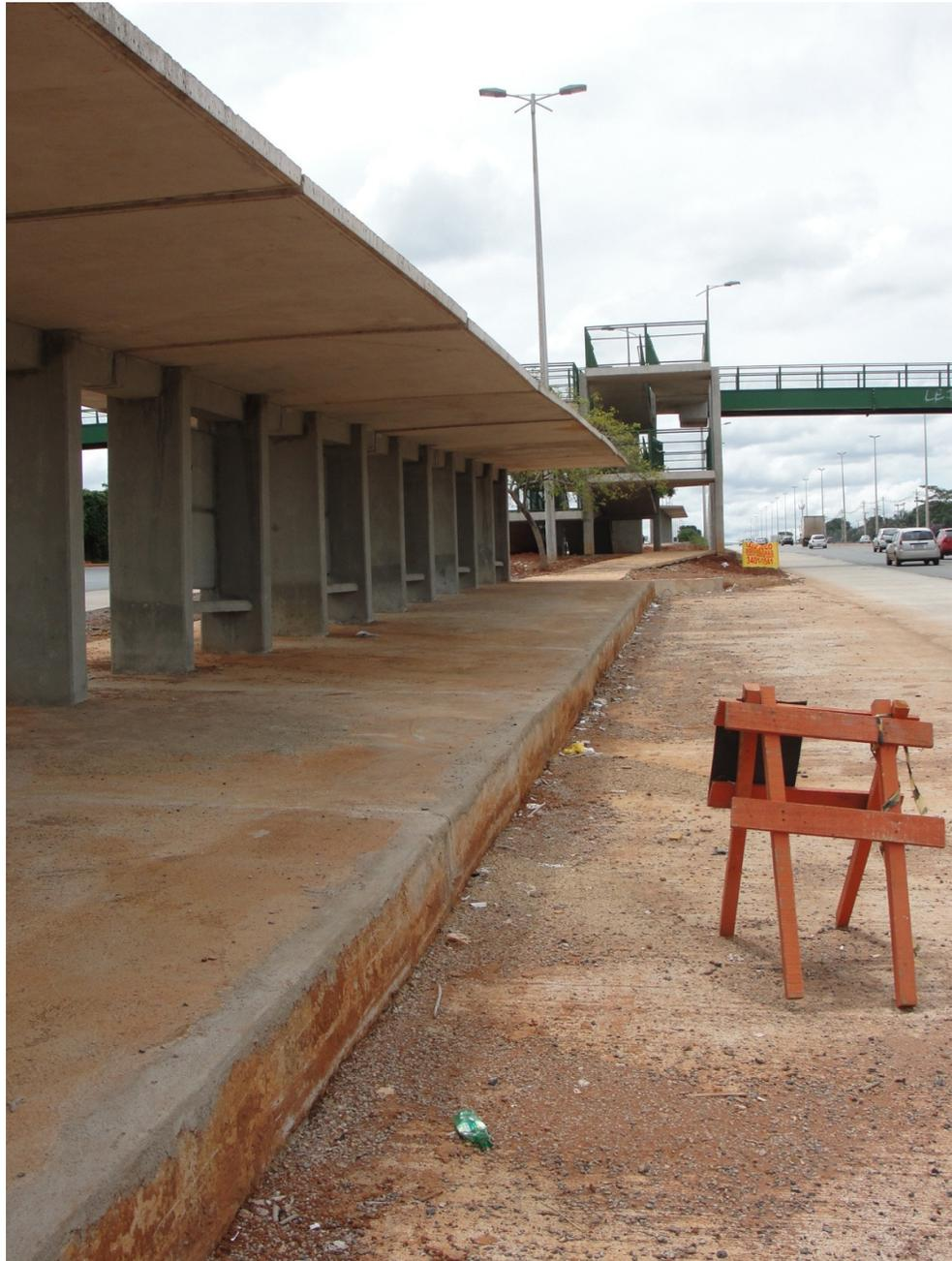
Fig. - Construção dos pontos: base de estrutura pré-fabricada, sem nenhum acabamento
