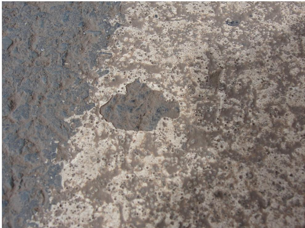
Fig. – Detalhe da baixa qualidade de execução da sinalização horizontal
