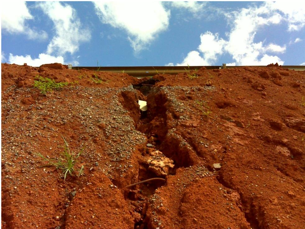
Fig. - Comprometimento de talude por erosão
