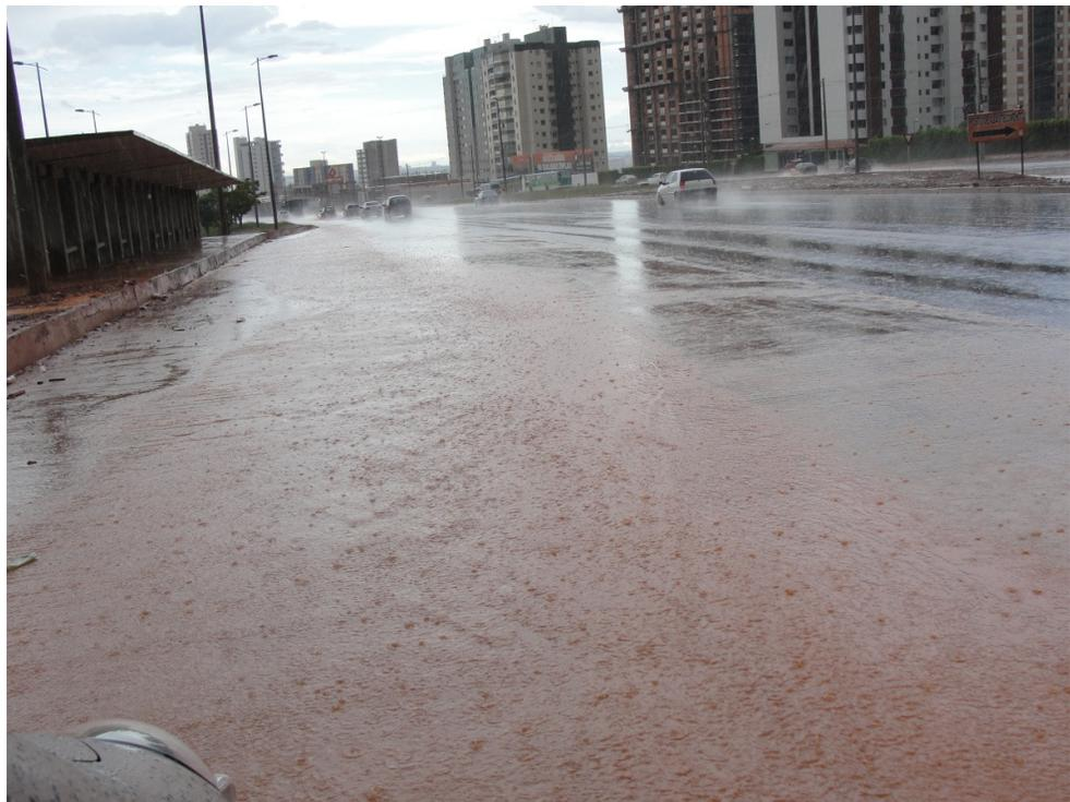
Fig. – escoamento de água pluvial por sobre a junção entre o pavimento rígido da via exclusiva e da baía de ônibus
