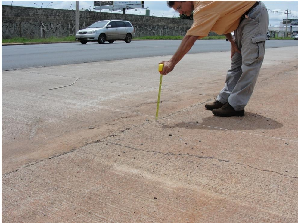
Fig. – Medição da altura da calha entre pavimento rígido e baía de ônibus
