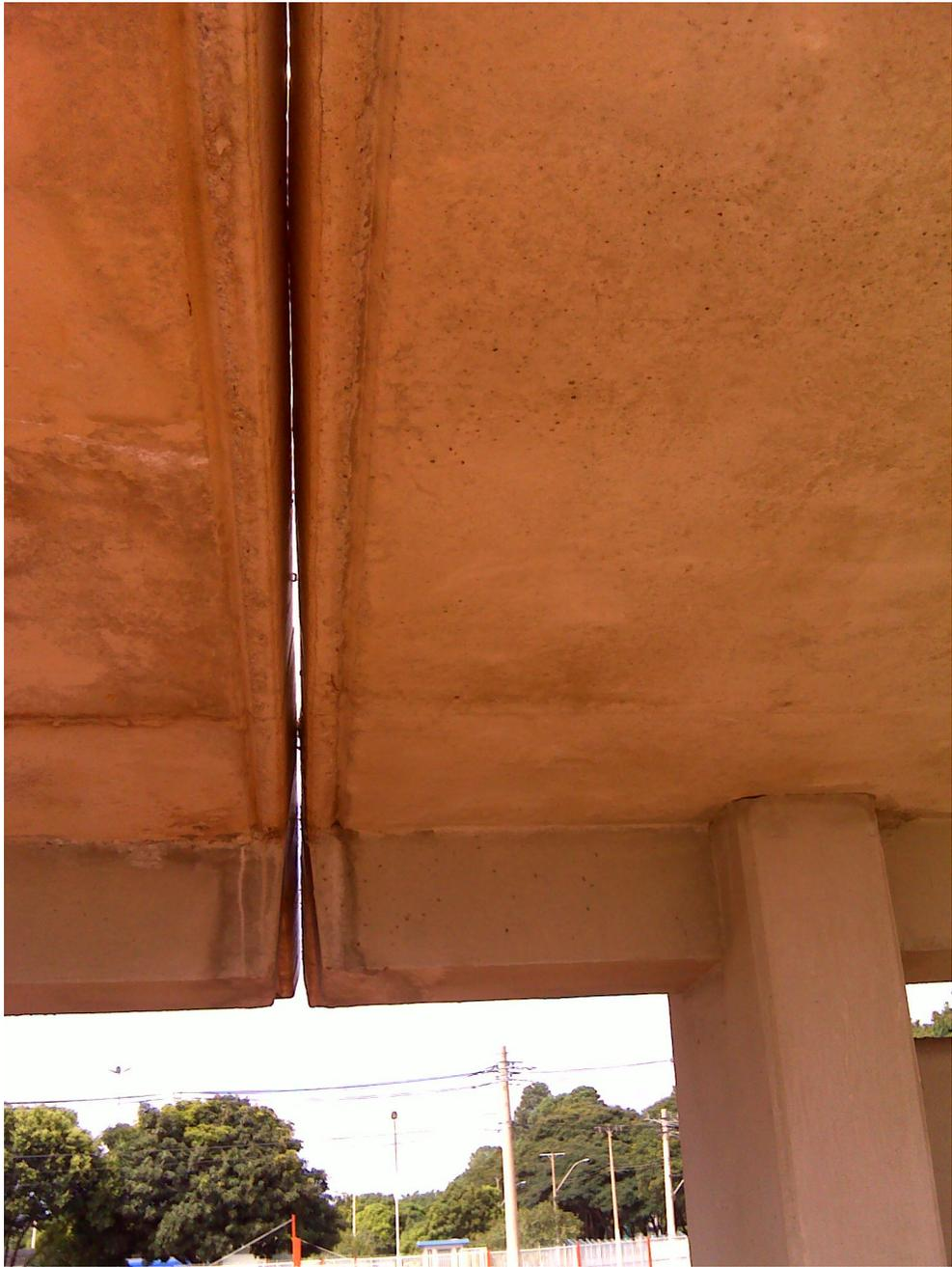
Fig. - Inexistência de escoamento no telhado
