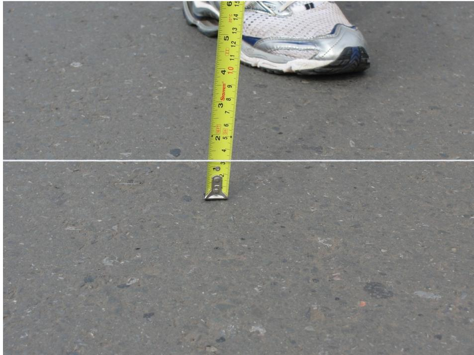
Fig. – Erro de concordância no pavimento flexível (3 cm de afundamento)
