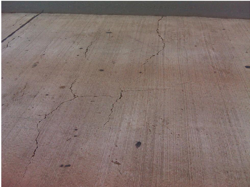
Fig. – Fissuras superficiais
