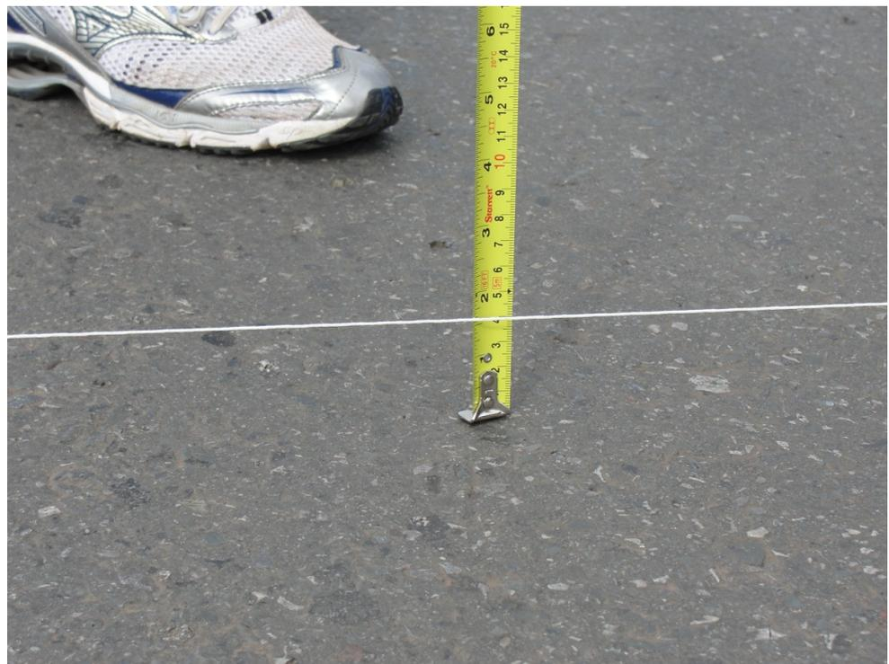
Fig. – Detalhe do erro de concordância (4 cm de afundamento)
