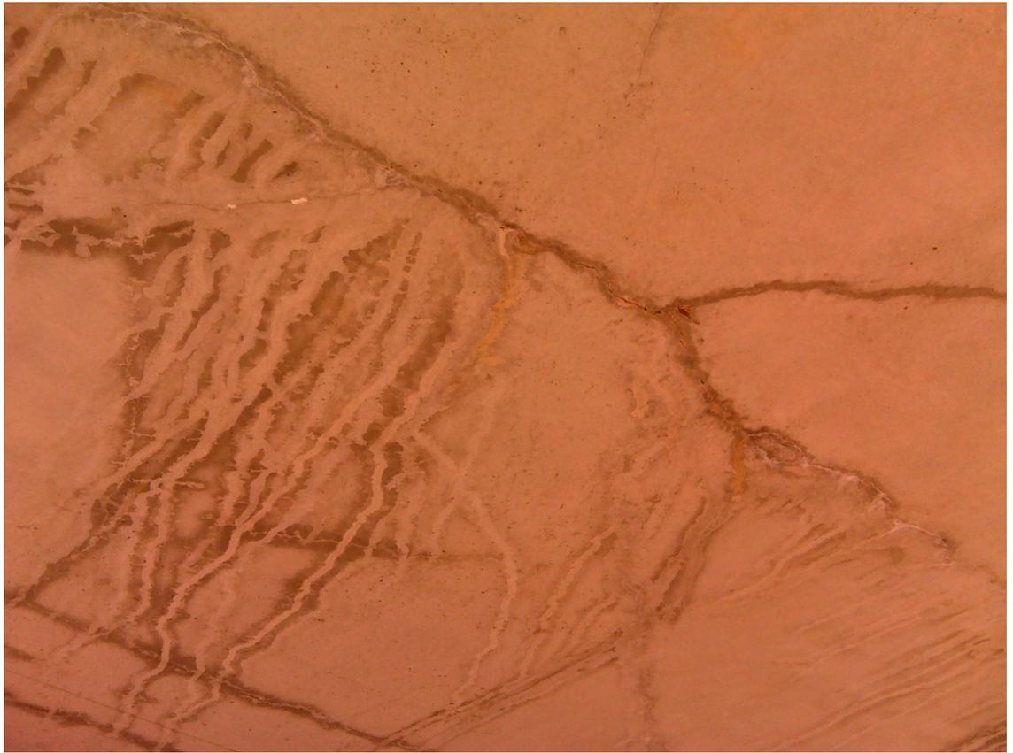
Fig. - Evidência de infiltração no teto das paradas e estações
