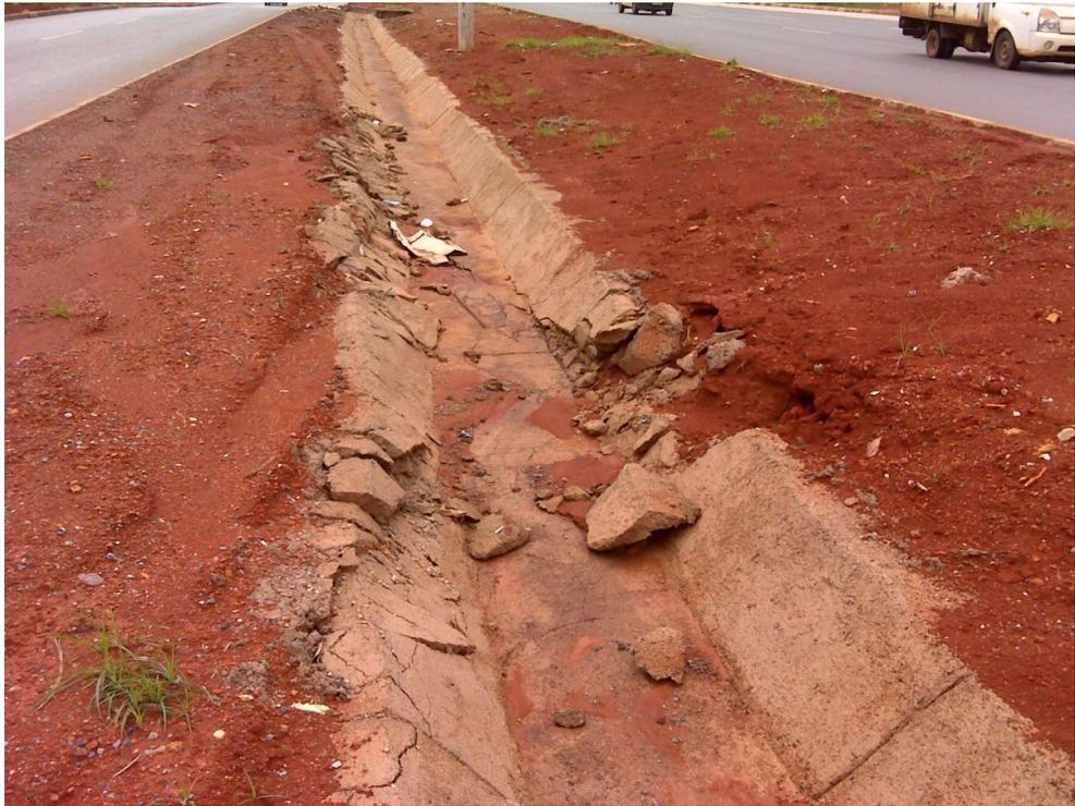
Fig. - Canaleta de drenagem danificada
