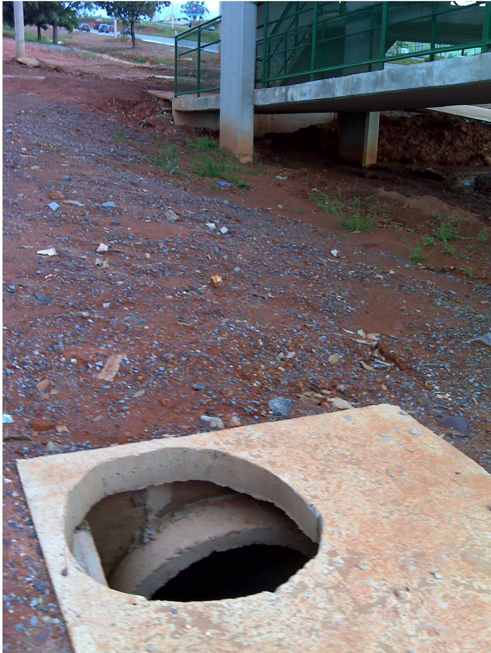
Fig. - Caixa de passagem sem proteção, próximo à passarela
