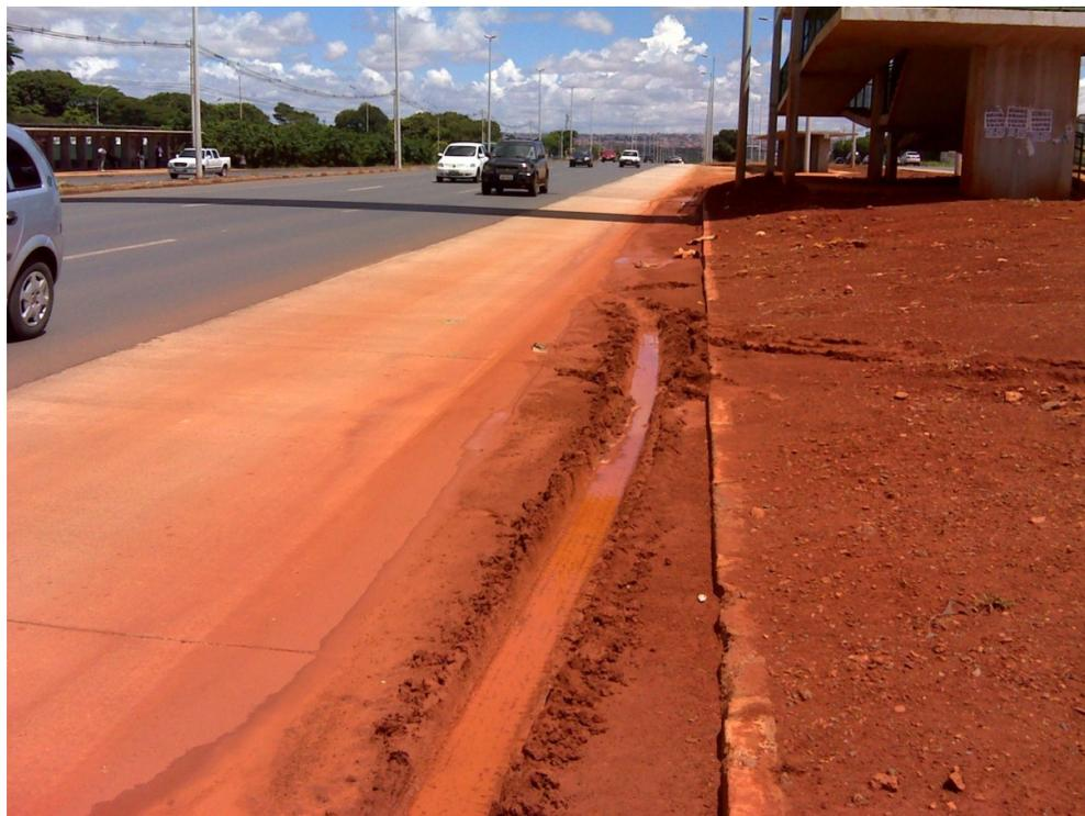
Fig. – Acúmulo de material oriundo do canteiro central na pista
