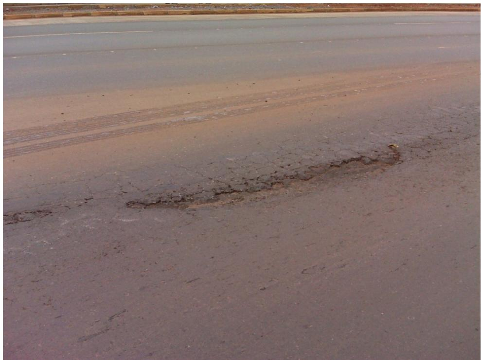
Fig. – Revestimento desgastado e panela
