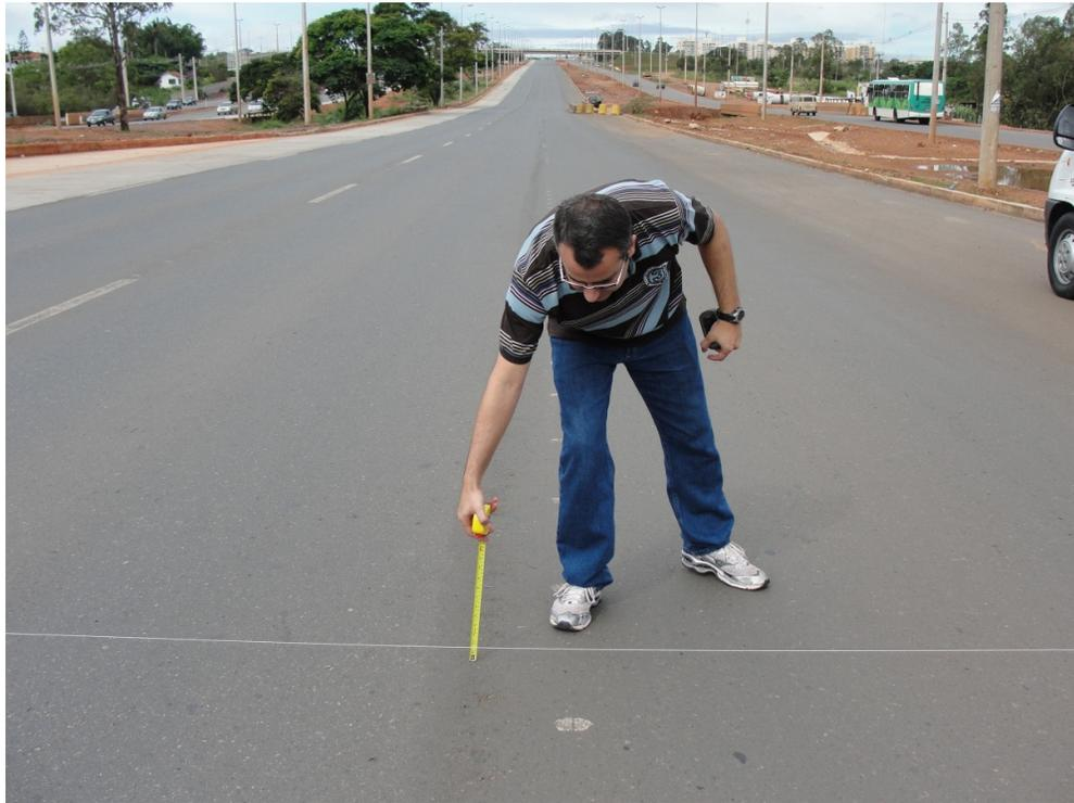
Fig. – Medição da erro de concordância longitudinal entre faixas 3 e 4 (pavimento flexível)
