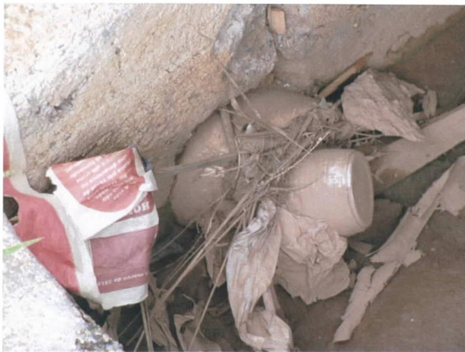
Fig. 12 – Tubo de escoamento na baía de ônibus entupido
