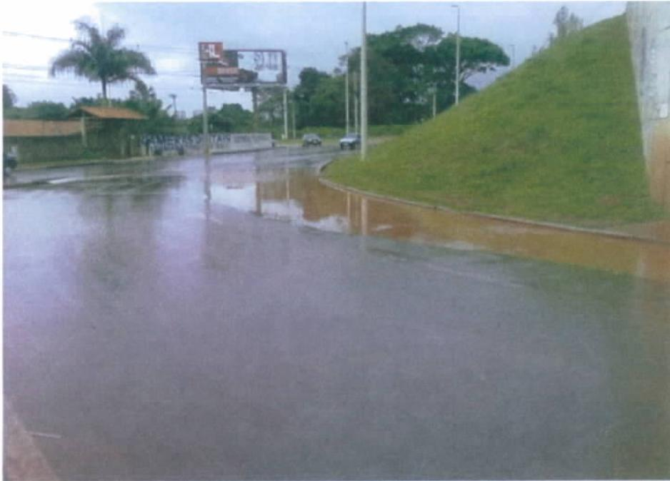
Fig. 11 – Sarjeta submersa (Foto retirada do Processo nº TCDF nº 5738/10)
