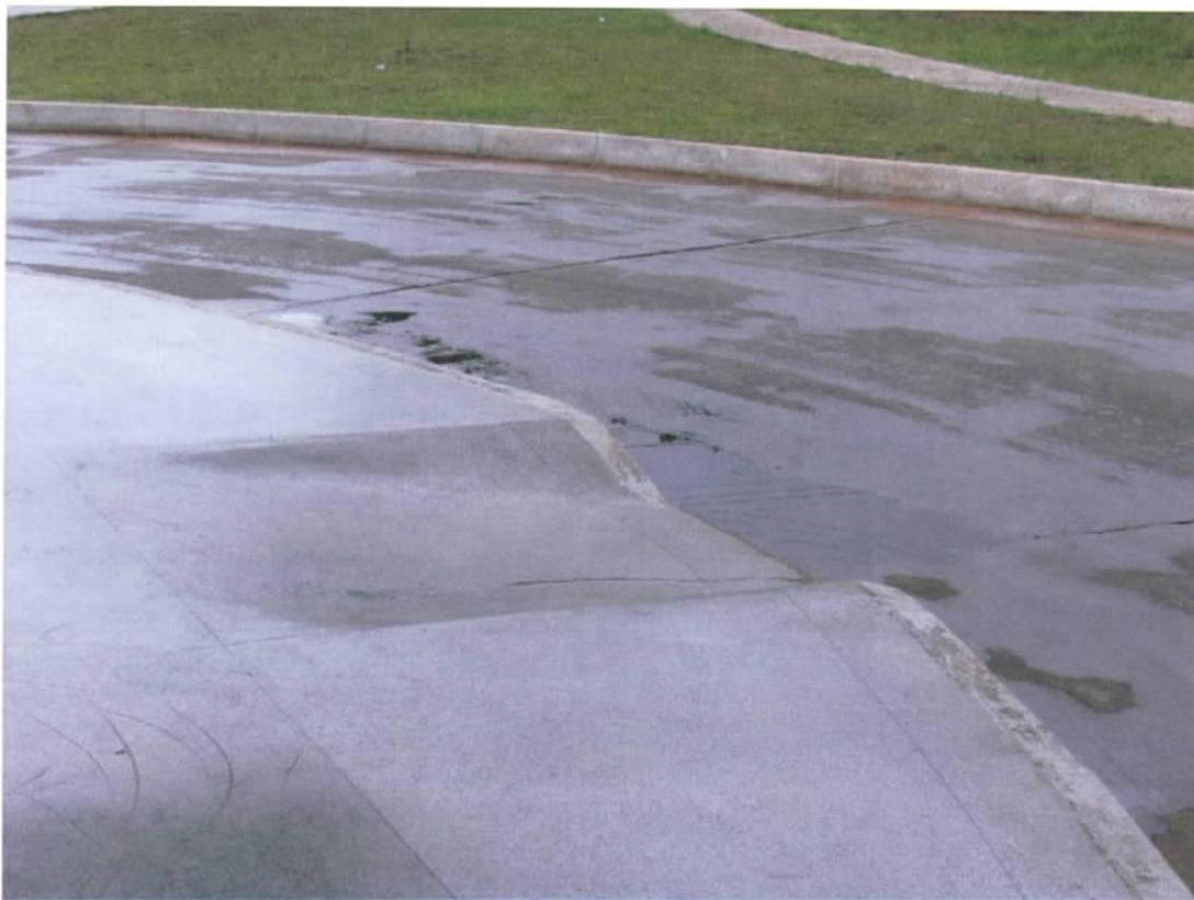
Fig. 22 – Faixa de pedestre sem pintura e rampa sem antiderrapante
