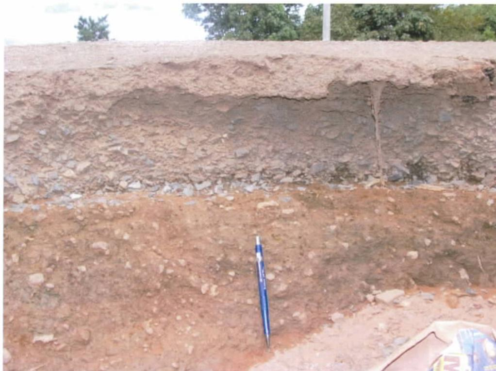
Fig. 16 – Detalhe da sub-base em solo-cal e da base em brita graduada (com 20 cm de espessura) no trecho entre as estacas 15 e 34
