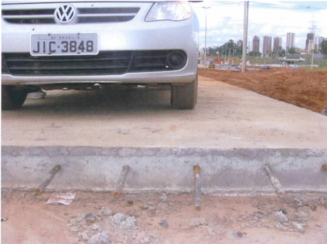
Fig. 22 – Detalhe das juntas de ligação no início do pavimento rígido
