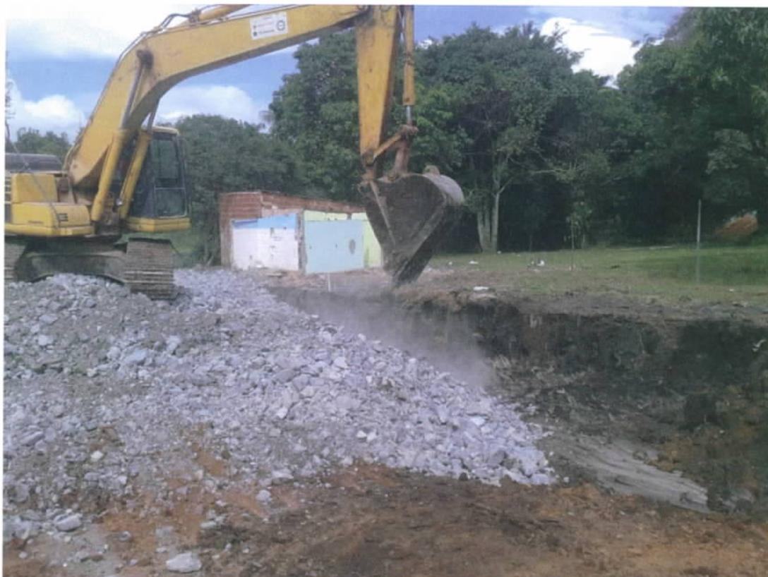
Fig. 28 – Aplicação de rachão em terreno com solo mole
