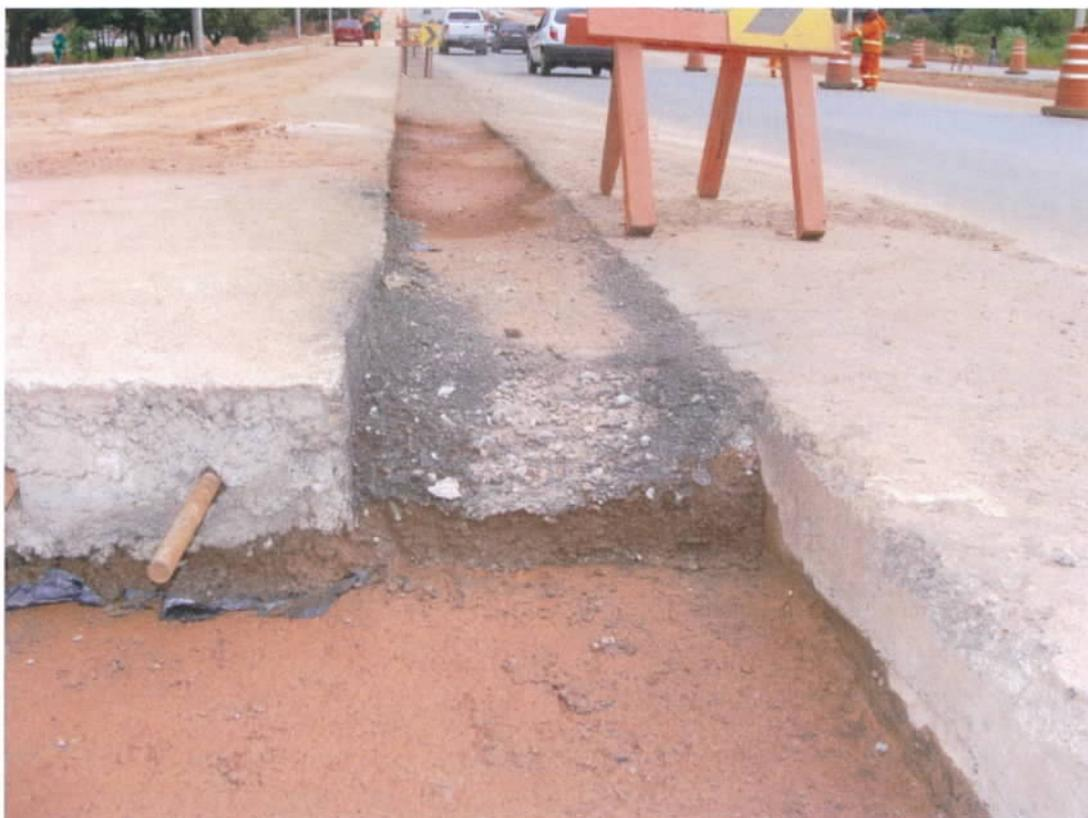
Fig. 14 – Detalhe do acabamento temporário entre pavimentos rígido e flexível
