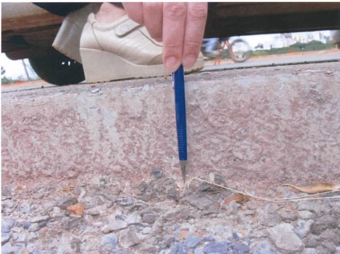
Fig. 09 – Espessura da capa asfáltica parcial (8 cm)
