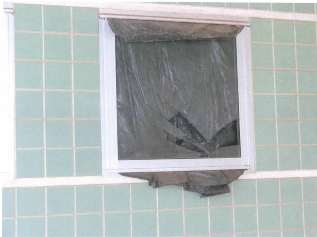
Fig. 38 – Janela com o vidro quebrado no Módulo A
