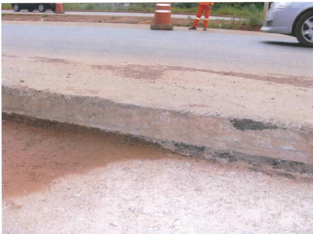
Fig. 15 – Junção da base de concreto compactada a rolo com o pavimento flexível em trecho sem pavimento rígido executado
