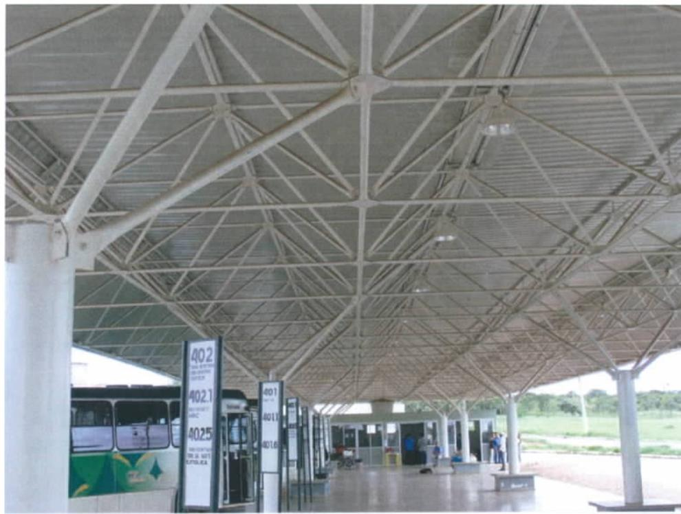
Fig. 06 – Vista da estrutura metálica da cobertura e Módulo B
