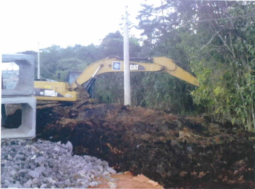
Fig. 42 – Remoção de solo mole no local
