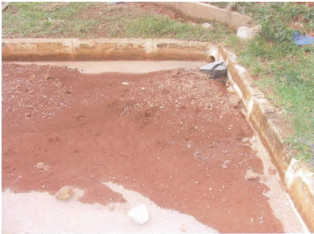
Fig. 47 – Lama e terra trazidas pelas águas da chuva
