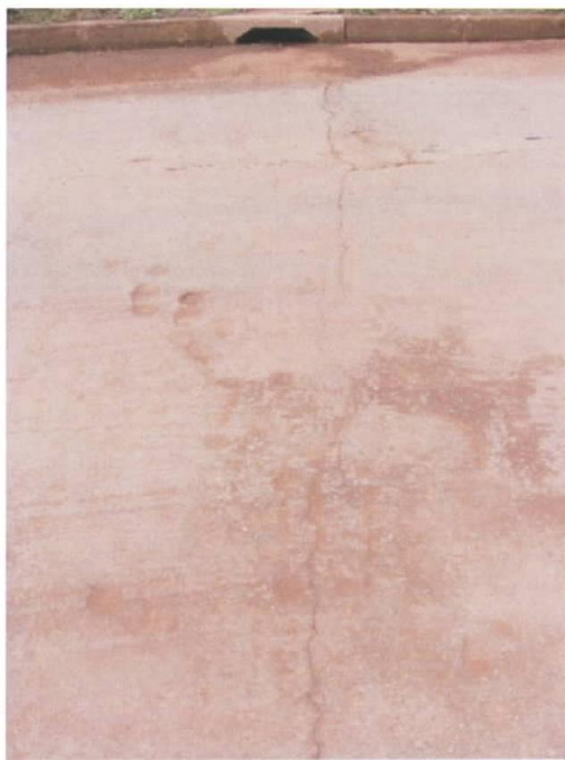
Fig. 43 – Pegadas e trinca no pavimento rígido
