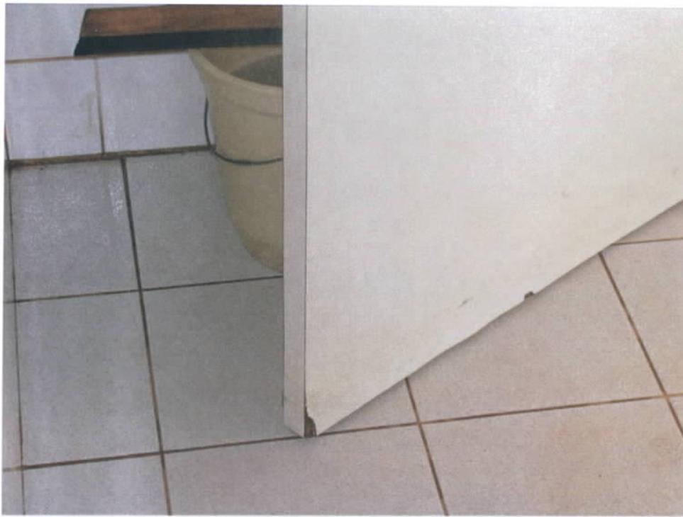
Fig. 40 – Porta do banheiro com evidência de uso de material inadequado para área molhadas
