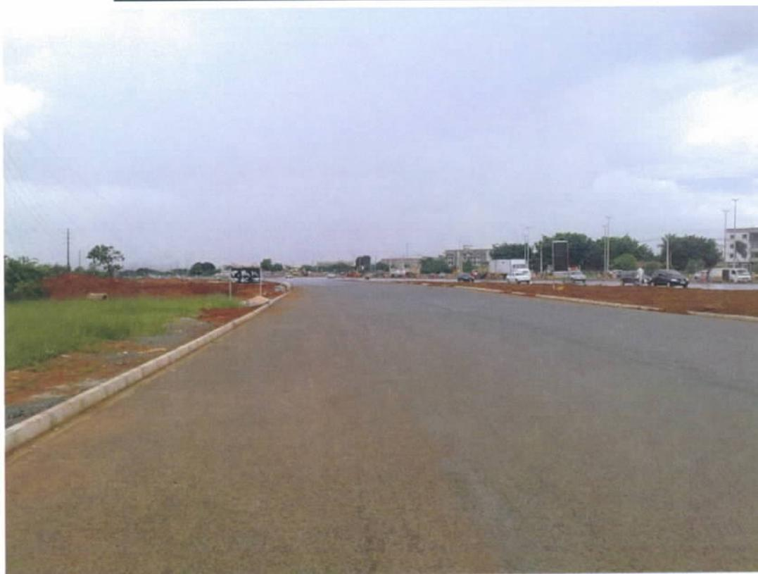
Fig. 45 – Marginal Norte com três faixas com pavimento flexível executado
