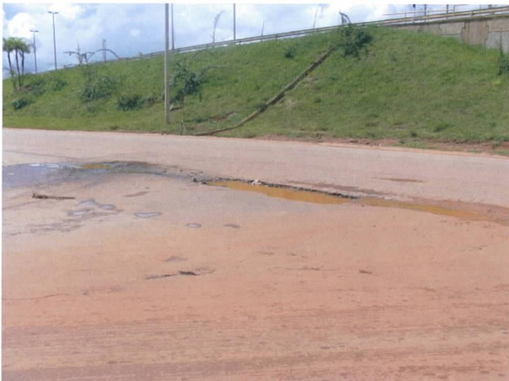
Fig. 07 – Deterioração do pavimento na Marginal Norte na área sujeita a alagamento
