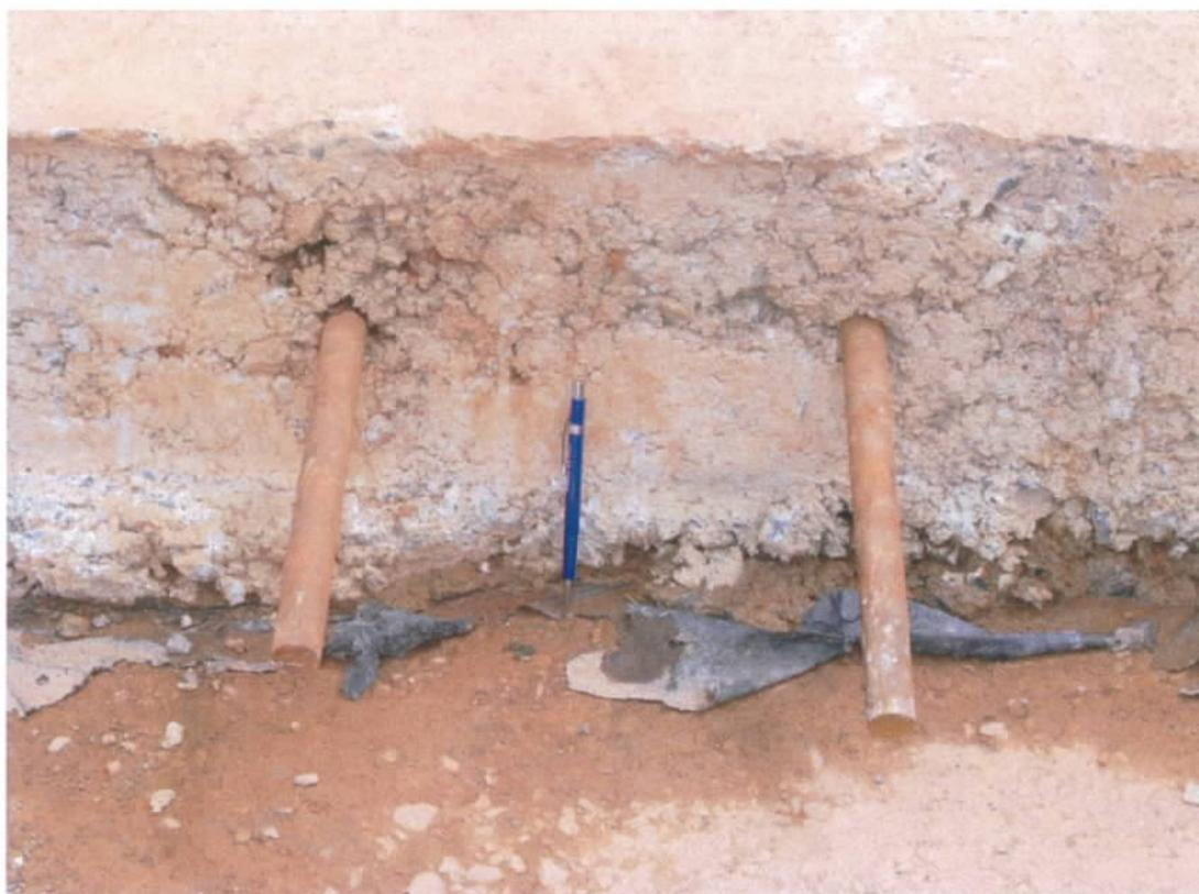
Fig. 13 – Final de trecho revelando a espessura de 22 cm do pavimento rígido
