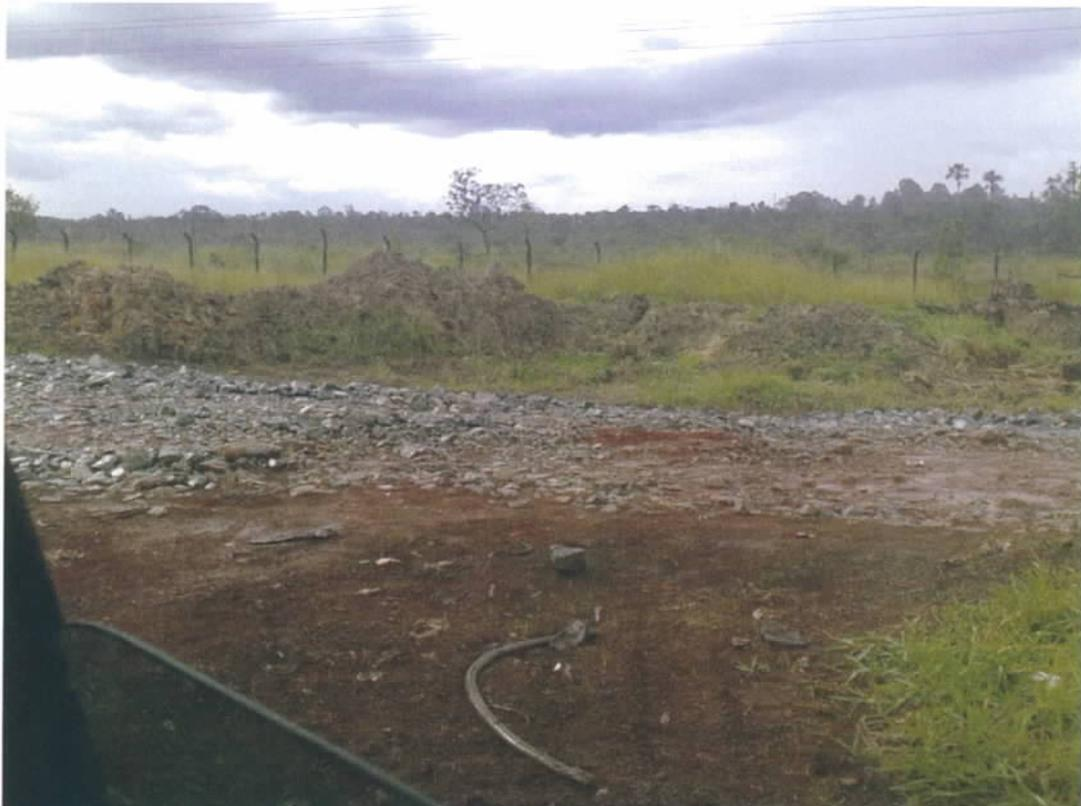
Fig. 43 – Evidência da aplicação de rachão na Marginal Norte
