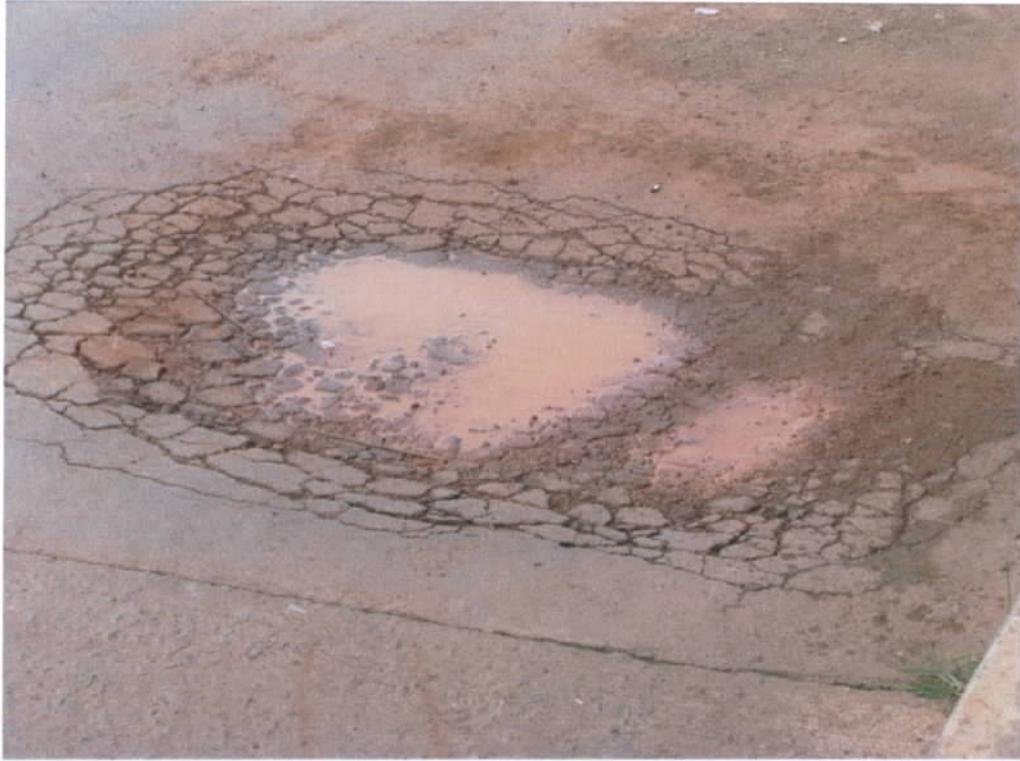
Fig. 10 – Pavimento asfáltico já danificado em razão de alagamento por águas das chuvas
