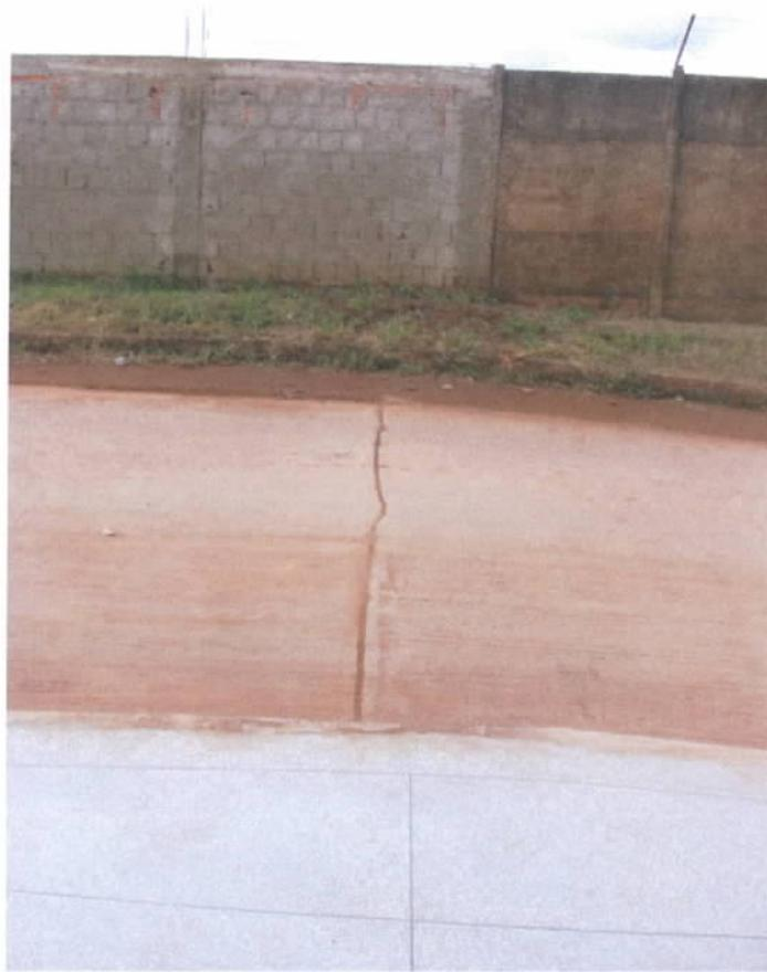
Fig. 44 – Junta de dilatação desalinhada
