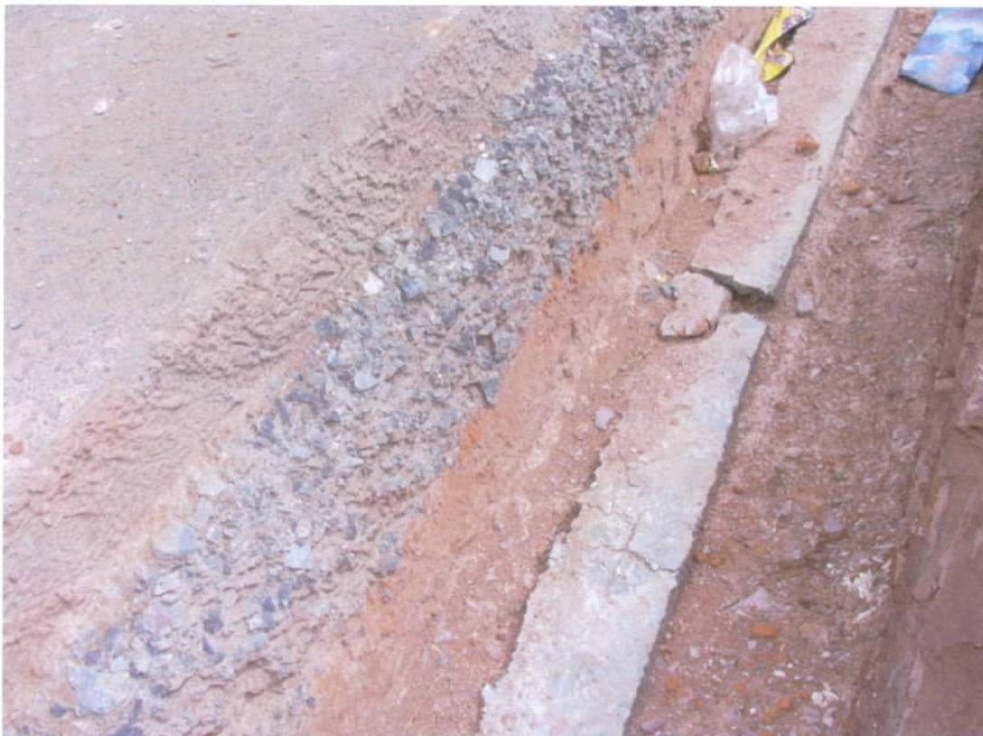
Fig. 10 – Três camadas visíveis (capa asfáltica, base de brita graduada e sub-base de solo-cal)
