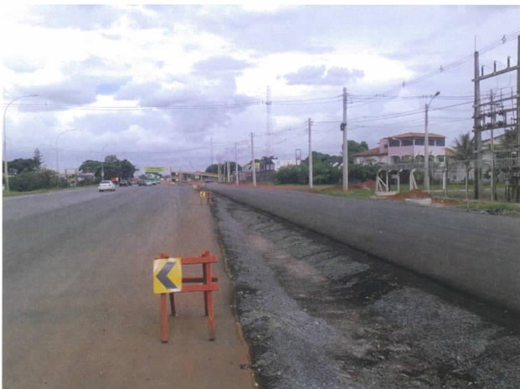
Fig. 33 – Trecho fresado e já pavimentado na expressa sul e capa asfáltica recém aplicada em sua marginal
