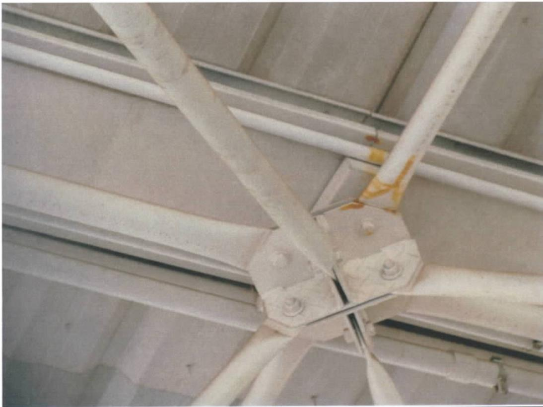
Fig. 17 – Detalhe da cobertura metálica revelando marcas de infiltração
