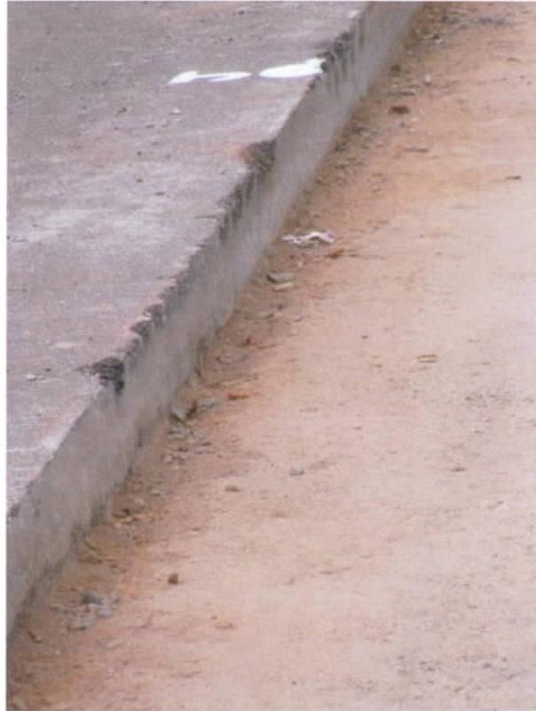
Fig. 20 – Detalhe da interface com o pavimento flexível
