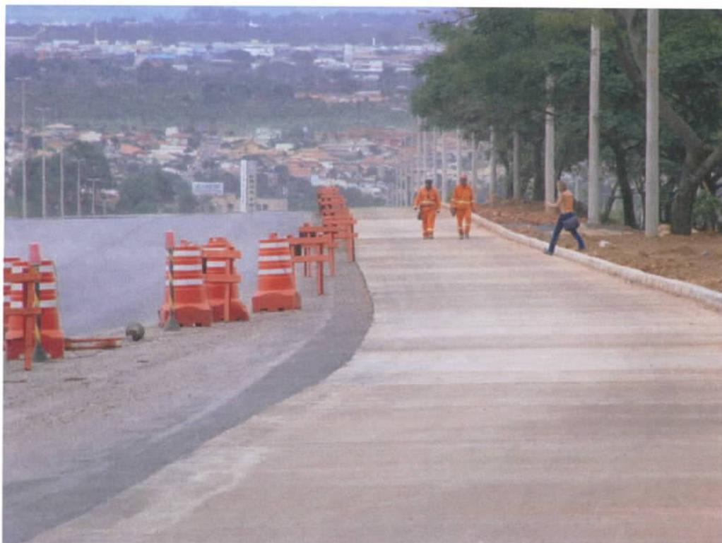
Fig. 24 – Detalhe do pavimento rígido com o meio-fio já concluído
