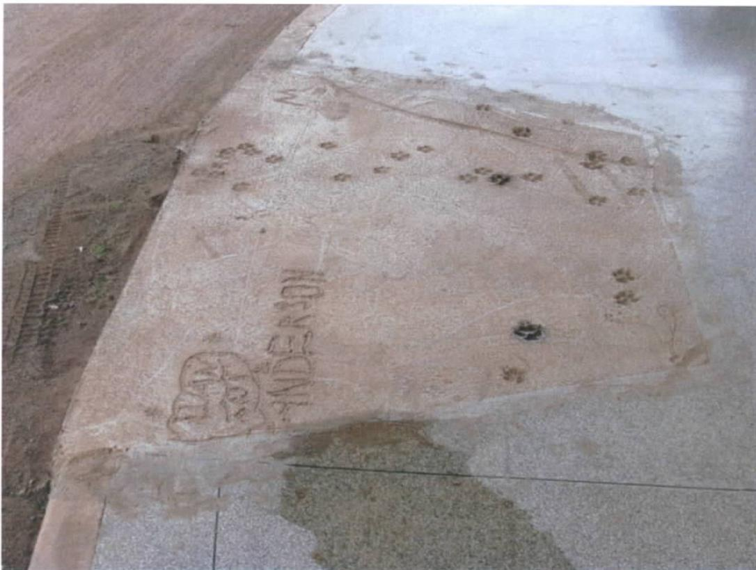
Fig. 08 – Rampa de acesso concretada em razão da invasão de águas pluviais
