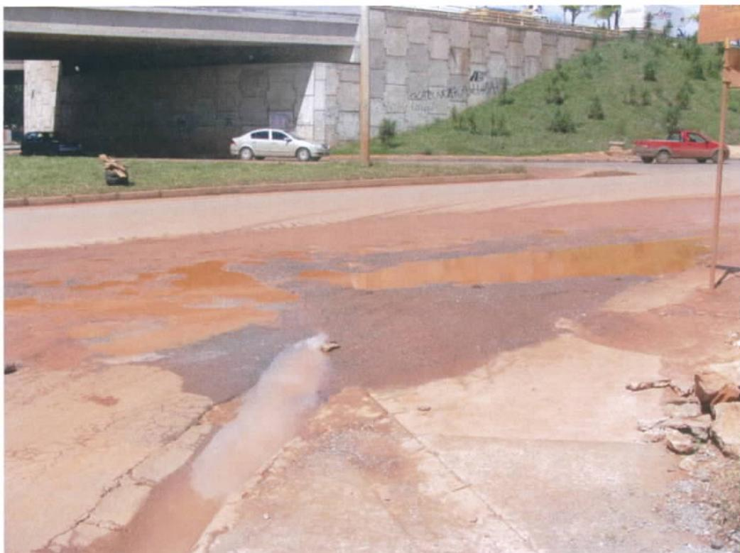
Fig. 08 – Erosão na Marginal Norte causada por alagamentos
