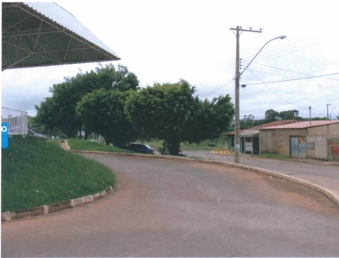
Fig. 02 – Via de contorno em pavimento rígido
