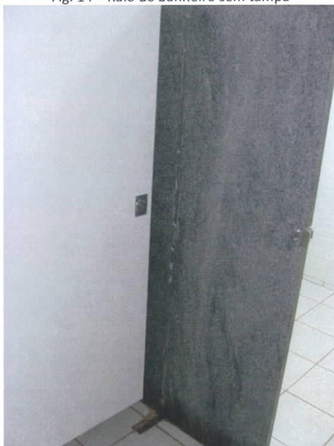
Fig. 15 – Box de vaso sanitário com o portal quebrado
