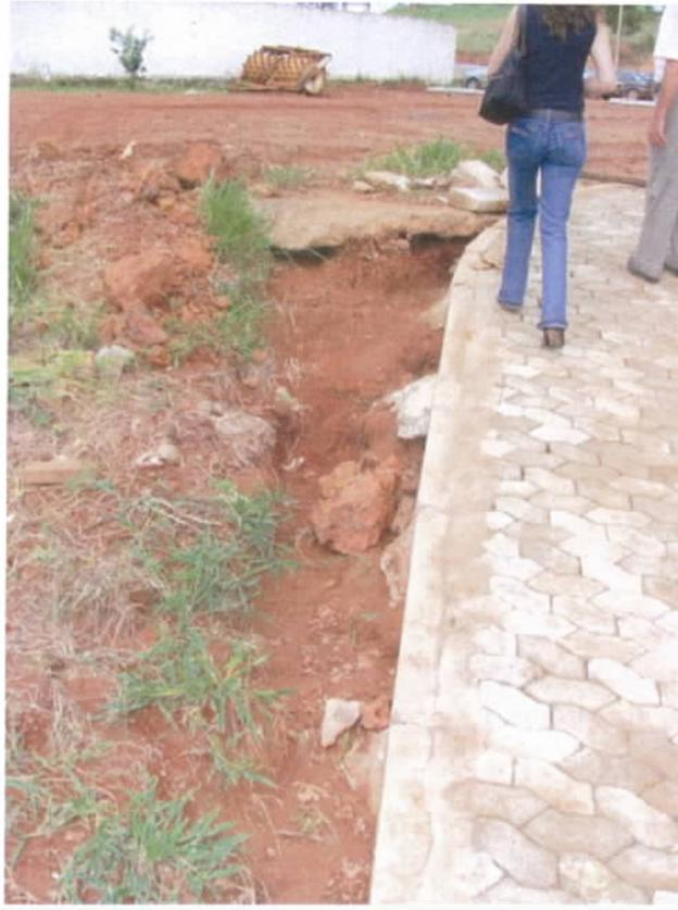
Fig. 46 – Evidência de erosão decorrente águas pluviais da região que escoam para o terminal
