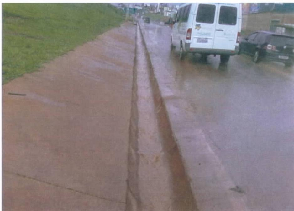
Fig. 10 – Sarjeta profunda sem elemento de proteção contígua à faixa de rolamento (Foto retirada do Processo nº TCDF nº 5738/10)
