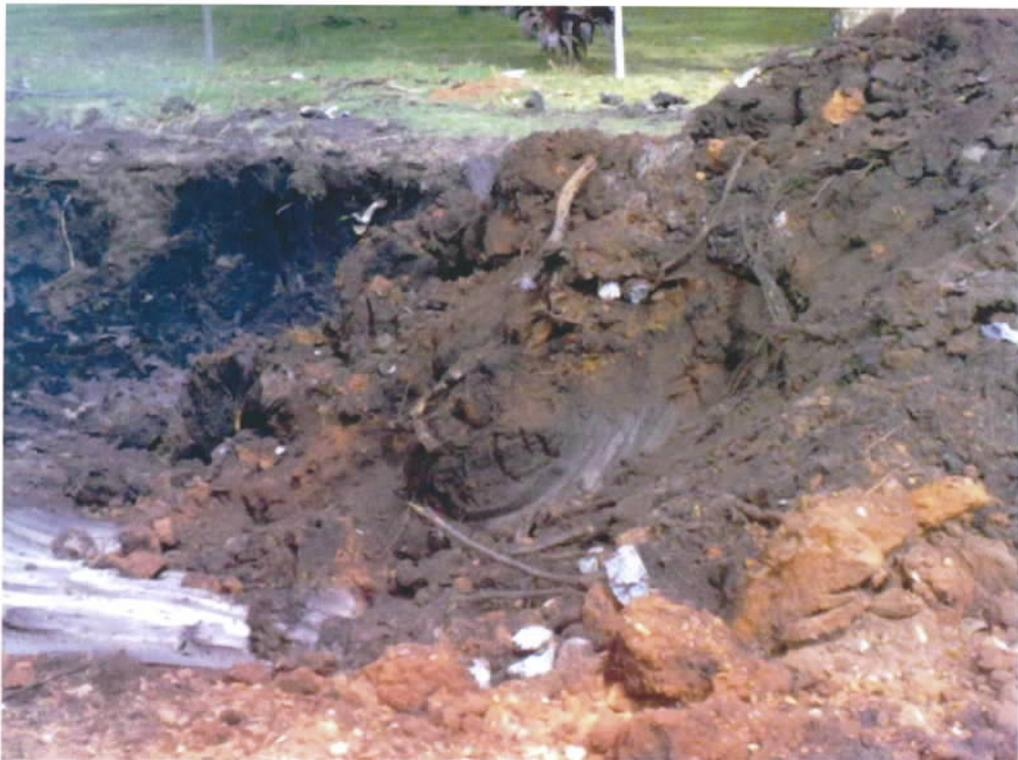
Fig. 27 – Detalhe de solo mole sendo removido
