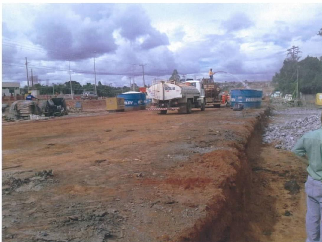
Fig. 29 – Vista da Via Marginal Sul e aplicação de rachão em sua faixa lateral
