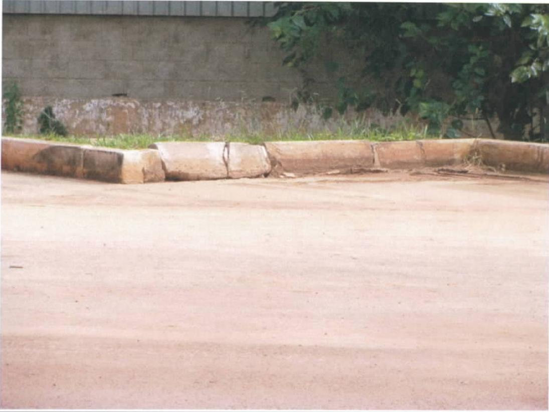
Fig. 34 – Meio-fios danificados nas baias de estacionamento de ônibus
