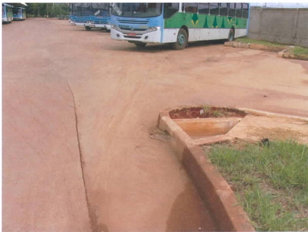
Fig. 45 – Recuperação de pavimento rígido defeituoso por meio massa asfáltica (CBUQ)
