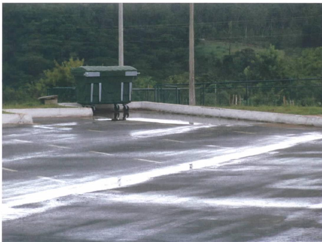
Fig. 31 – Área de estocagem de ônibus com deficiência de escoamento
