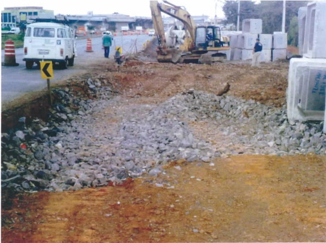
Fig. 40 – Aplicação de Rachão na via Marginal Sul
