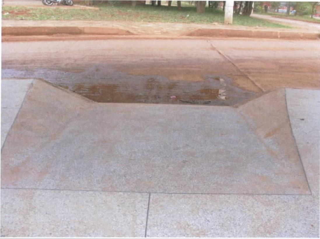
Fig. 36 – Faixa de pedestre sem pintura e rampa sem antiderrapante
