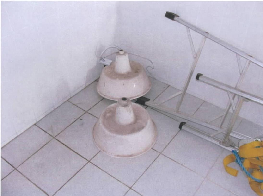
Fig. 27 – Luminárias retiradas pela empreiteira em razão de curto-circuito
