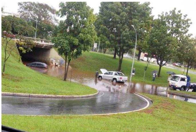
Imagem 13: Falhas na drenagem urbana - Inundação tesourinha 209 Norte
