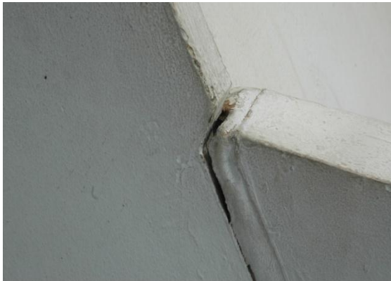
Detalhe das emendas das muretas laterais junto ao acesso ao mezanino do Museu.
