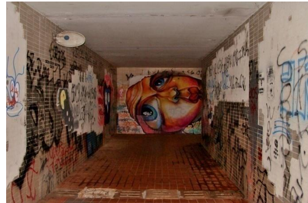
Passagem subterrânea das SQN 115/215.
