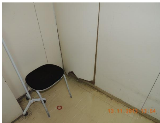
Fotos 21,22,23 e 24: Hospital de Base do DF – buracos e revestimento inapropriado na cobaltoterapia
