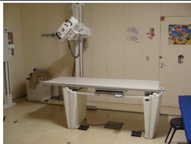
Foto 28: Hospital Regional de Brazlândia – piso e paredes inadequadas na sala do RX
