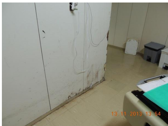
Fotos 21,22,23 e 24: Hospital de Base do DF – buracos e revestimento inapropriado na cobaltoterapia
