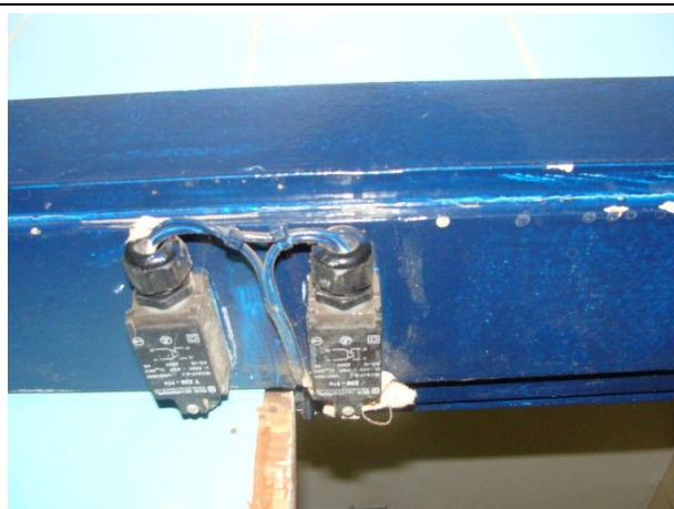
Fotos 29 e 30: Hospital Regional de Planaltina – dispositivos de segurança da porta e sala do RX fixo inadequados
