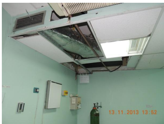
Fotos 17, 18, 19 e 20: Hospital de Base do DF – paredes e forros inadequados no acelerador linear
