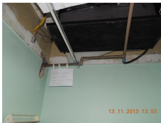
Fotos 17, 18, 19 e 20: Hospital de Base do DF – paredes e forros inadequados no acelerador linear
