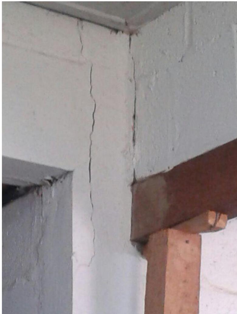
**Figura 16 - Viga escorada provisoriamente com madeira**
