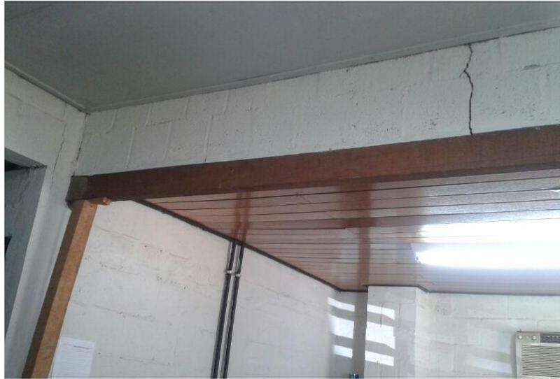
**Figura 15 - Viga (escorada com madeira) com rachadura central**
