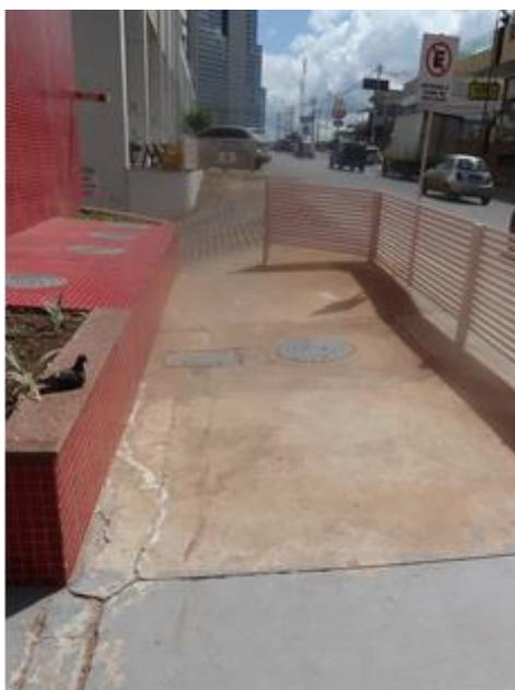
Figura 27 - Passeio descontínuo/ desnivelado entre lotes vizinhos no trajeto para a Estação de Metrô Concessionárias.
