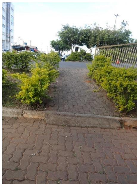
Figura 77 - Rampa inadequada no Hospital de Samambaia.
