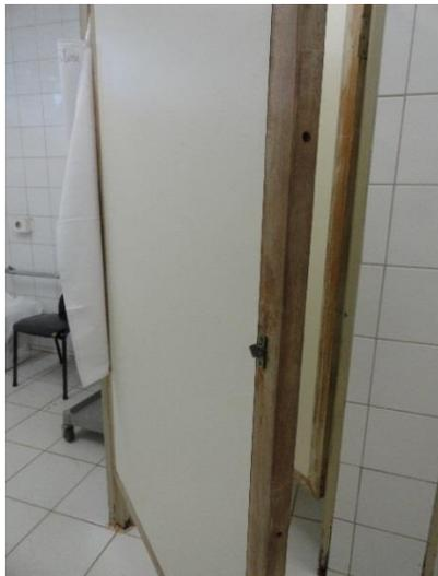
**Figura 117 - Banheiro sem maçaneta e sem barra na parte interna da porta no Hospital Regional de Planaltina.**
