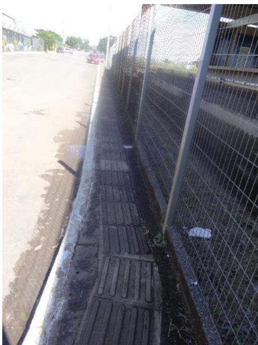
**Figura 31 - Passeio com largura inadequada no trajeto para a Estação de Metrô Feira.**
