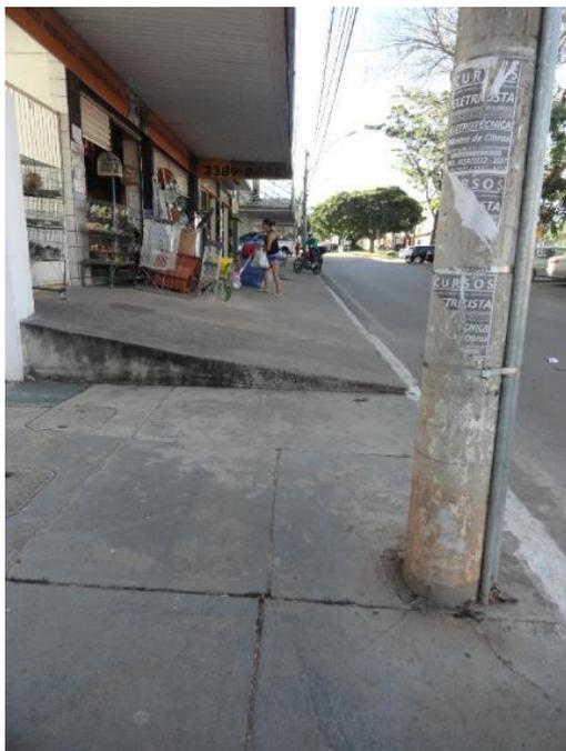
**Figura 29 - Passeio com inclinação inadequada no trajeto para o DETRAN de Planaltina.**
