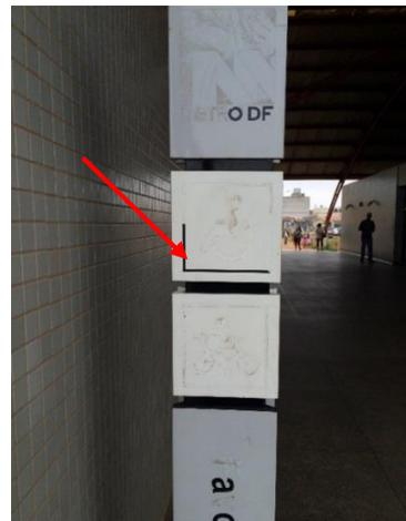
**Figura 83 - Ausência de sinalização da entrada acessível na estação Furnas - por falta de manutenção do totem.**
