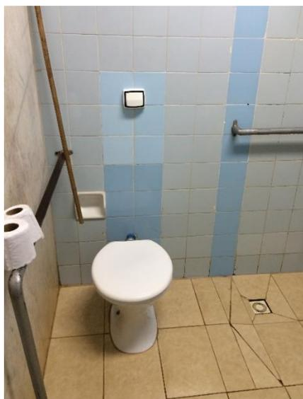
**Figura 121 - Instalação inadequada das barras no banheiro do Centro de Ensino Especial 01 de Brasília.**
