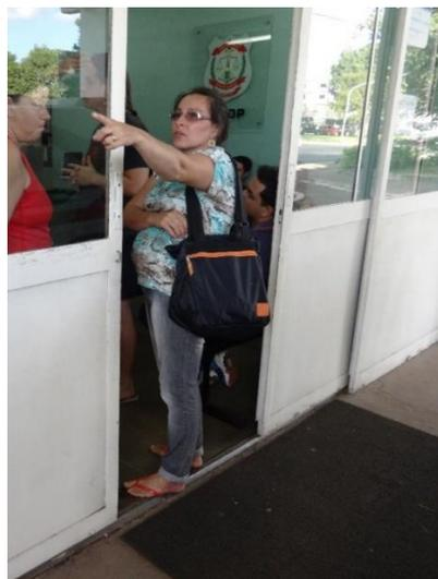
**Figura 89 - Trilho não nivelado, largura da porta inadequada e espaço insuficiente para a manobra de cadeira de rodas na entrada da 17ª DP.**
