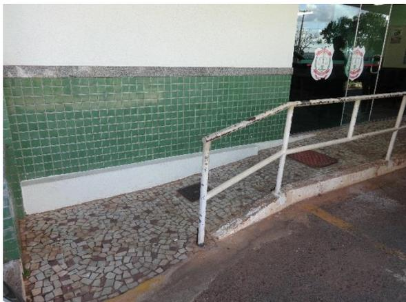
Figura 107 - Rampa inadequada na entrada da 26ª DP.
