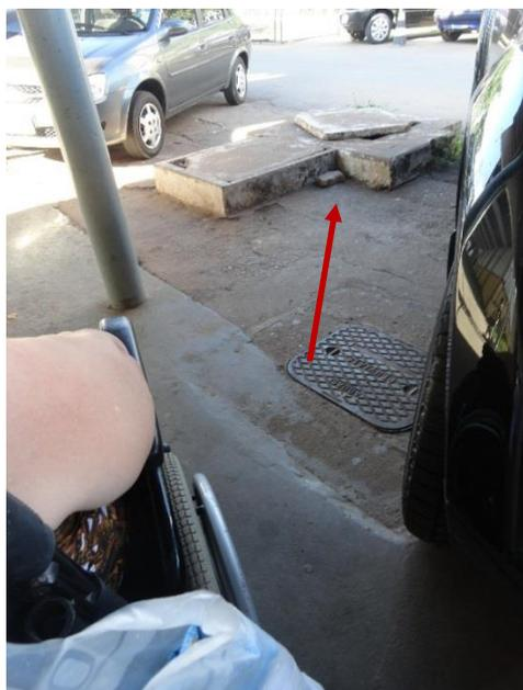
**Figura 71 - Caixa de inspeção não nivelada impedindo a passagem de cadeirante no Hospital Regional do Gama.**
