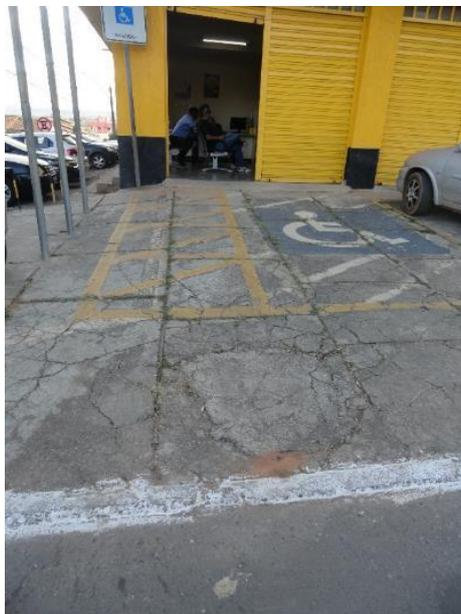
Figura 103 - Rampa inadequada na entrada do DETRAN de Planaltina.
