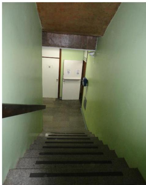
Figura 101 – Escada sem corrimão adequado e sem piso tátil de alerta no Hospital Regional do Guará.
