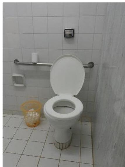
**Figura 122 - Ausência de barra lateral no sanitário no DETRAN do Gama.**
