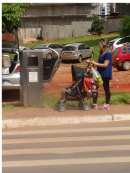
**Figura 63 - Ausncia de rampa na travessia de via no trajeto para a Estcao Concessionrias.**
