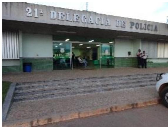
Figura 108 - Ausência de rampa e inadequação da escada para acesso à 21ª DP.
