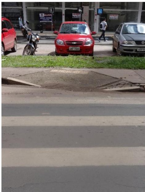
**Figura 61 - Rampa inadequada no trajeto para a Estação Arniquireiras.**
