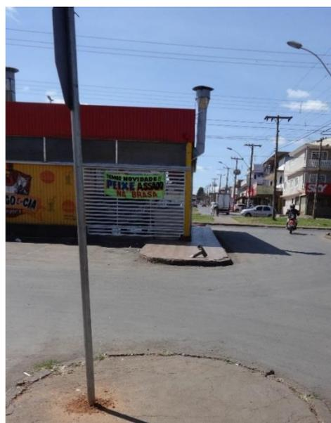
Figura 60 - Ausência de rampa para travessia de via no trajeto para a 19ª DP em Ceilândia.
