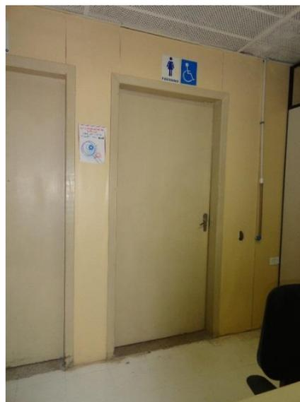
Figura 116 - Banheiro sem sinalização tátil e com sinalização visual localizada a uma altura inadequada na Escola de Trânsito de Brasília.
