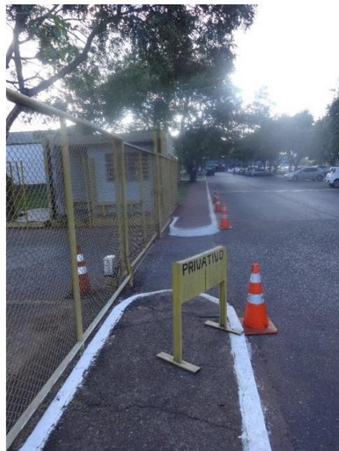
**Figura 79 - Rebaixamento da guia para passagem de veículos desrespeitando o passeio no Procon do Guará.**
