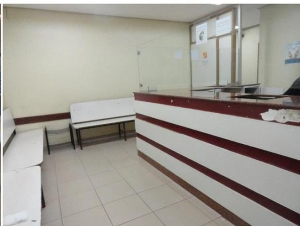
Figura 112 – Mobiliário com altura inadequada e sem recuo inferior no Hospital Regional de Samambaia.
