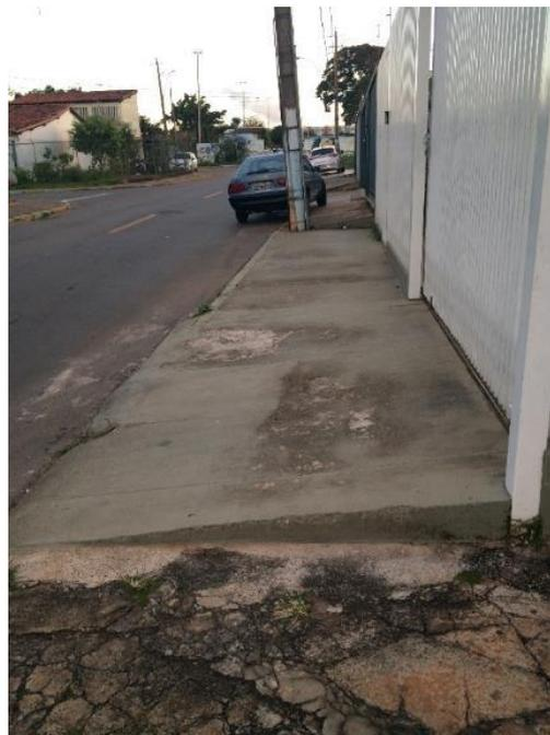
**Figura 30 - Passeio com inclinação inadequada no trajeto para o CEE 01 de Taguatinga.**
