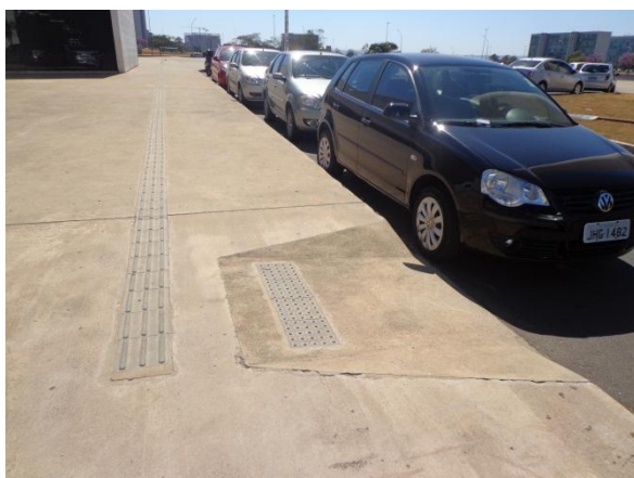
Falta de sinalização (placas e pintura).
