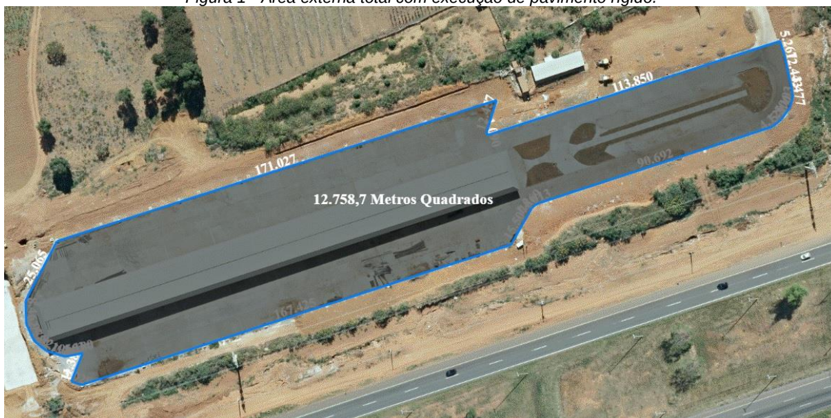
Figura 1 - Área externa total com execução de pavimento rígido.
