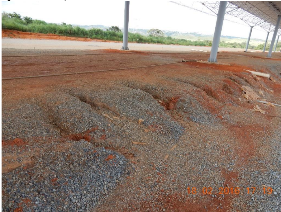
Figura 3 - Base da plataforma do Terminal de Samambaia Norte executado com solo.
