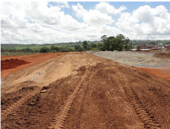
Figura 8 – Execução de sub-base no Terminal Samambaia Norte – com mistura solo-brita executada na pista.
