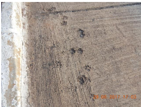
Marcas de pegadas no pavimento rígido de Taguatinga M Norte.
