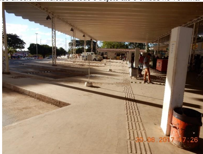
Figura 9 - Piso direcional indicando todo o trajeto até o ônibus no Terminal de Planaltina.
