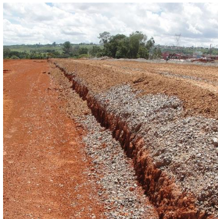
Figura 8 – Execução de sub-base no Terminal Samambaia Norte – com mistura solo-brita executada na pista.
