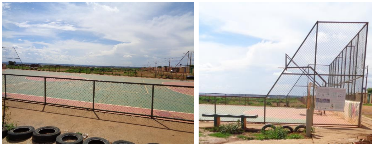
Figura 19 – Fotos da visita in loco referente à execução das obras na Ceilândia (Processo nº 138.000.196/2013)
