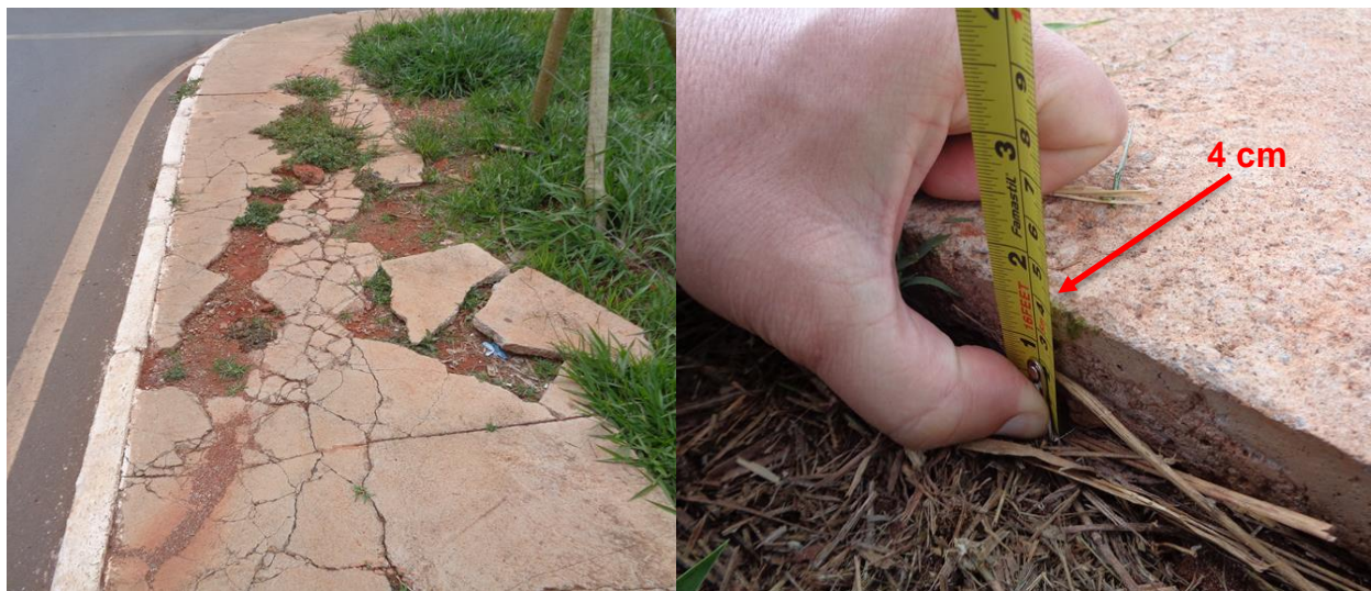
Figura 20 – Fotos da visita in loco referente à execução das obras em Santa Maria (Processo nº 143.000.405/2013)
