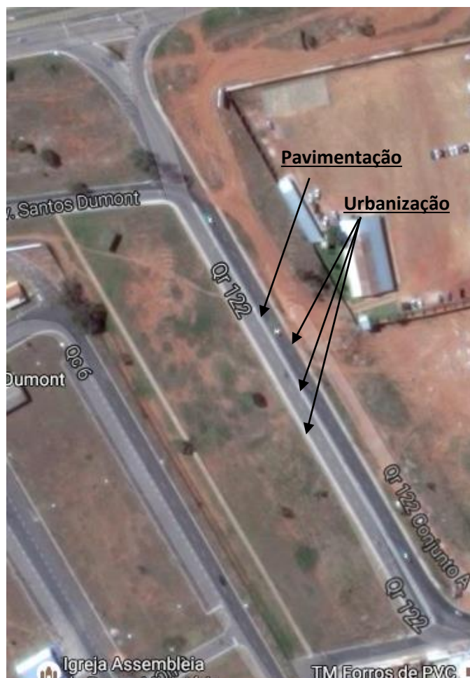
Figura 3 – Obra na QR 122 em Santa Maria
