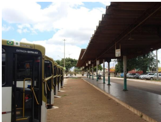
Figura 2: Cobertura Insuficiente do Terminal Ceilândia P Norte
