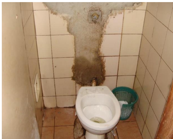
Figura 15: Vazamento de água e Entupimento do Terminal do Gama Centro
