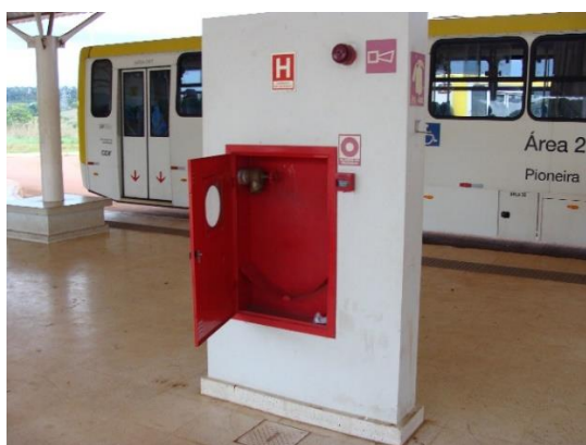
Figura 9 - Ausência de hidrante e extintor de incêndio no Terminal Gama Sul
