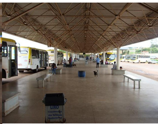
Figura 12: Ausência de Piso Tátil no Terminal de São Sebastião
