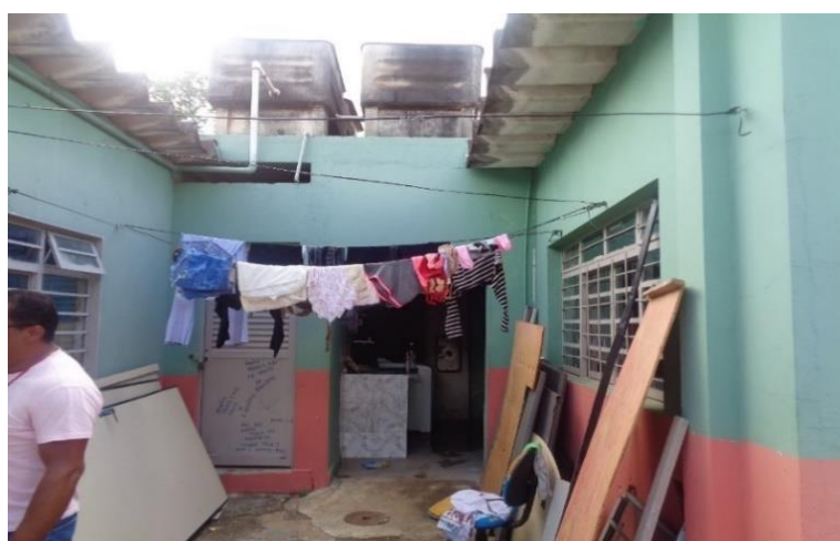
Imagem 17. Central de Acolhimento – Lavanderia e Depósito
