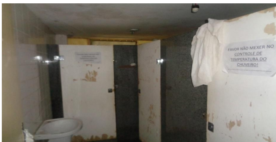
Imagem 12. Banheiro da UNAM
