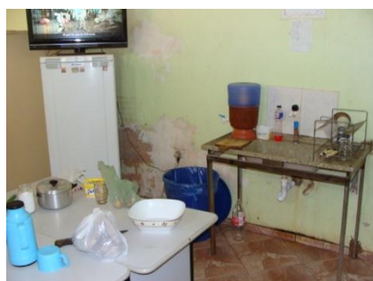
Foto 23: UBS Vila Estrutural – copa/cozinha improvisada
