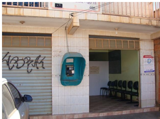
Foto 21: UBS Vila Estrutural UBS Galpão
