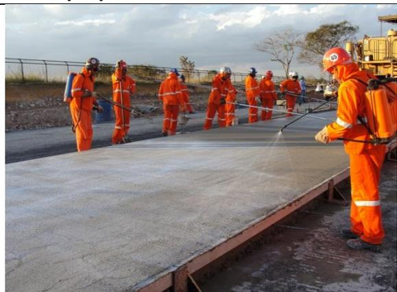
Foto 16 – Execução da cura química com bomba costal manual.
