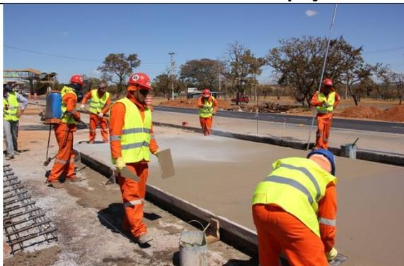
Foto 20 – Aplicação de cura química com bomba costal manual.
