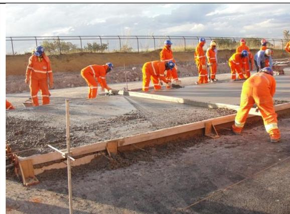
Foto 9 – Acabamento final com passagem de régua metálica.
