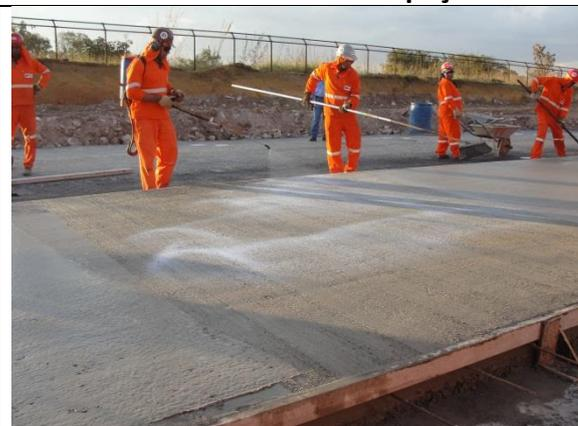
Foto 15 – Execução da cura química com bomba costal manual.
