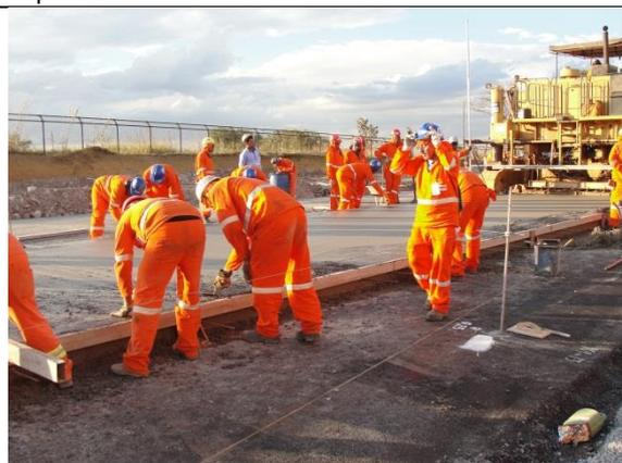
Foto 10 – Acabamento manual das bordas e detalhe da fôrma lateral.
