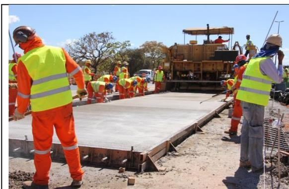
Foto 11 – Execução do pavimento rígido. Detalhe da presença constante da fôrma lateral.
