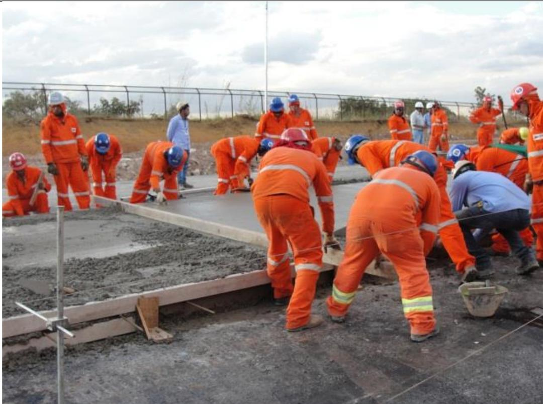
Foto 24 – Posicionamento de régua metálica e fixação manual de barras de ligação (canto direito).
