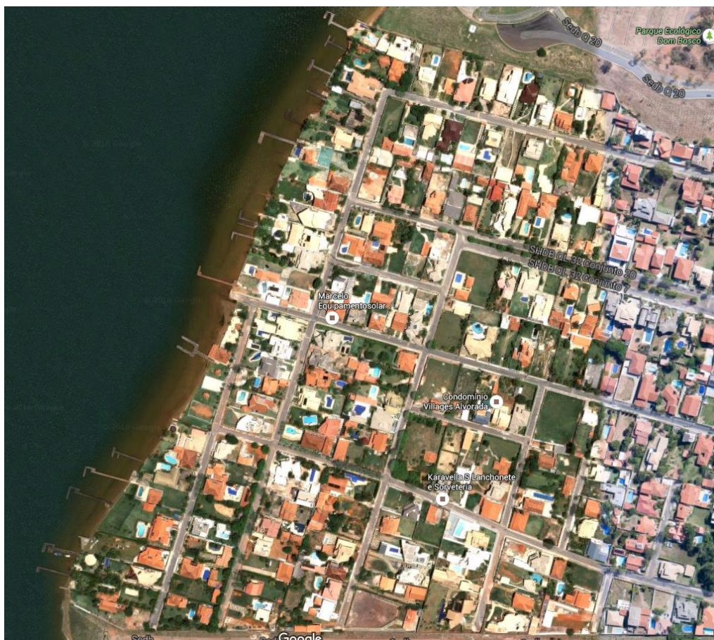
Figura 18 – Vista aérea de casas de alto padrão na Arine Dom Bosco I, ocupando a Orla do Lago Paranoá, com prejuízos ambientais (fonte googlemaps, pesquisado em 11.07.16)
