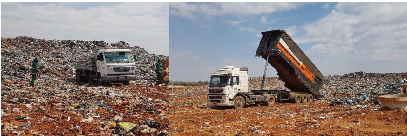
Figura 18 - Caminhões descarregando os rejeitos finais – Aterro Sanitário de Brasília
