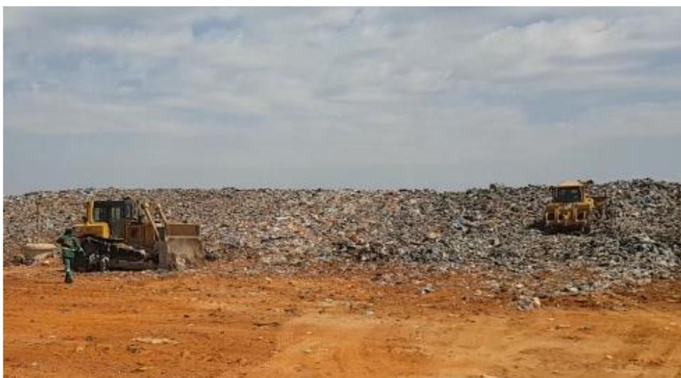
Figura 19 - Processo de compactação do lixo para aterro – Aterro Sanitário de Brasília
