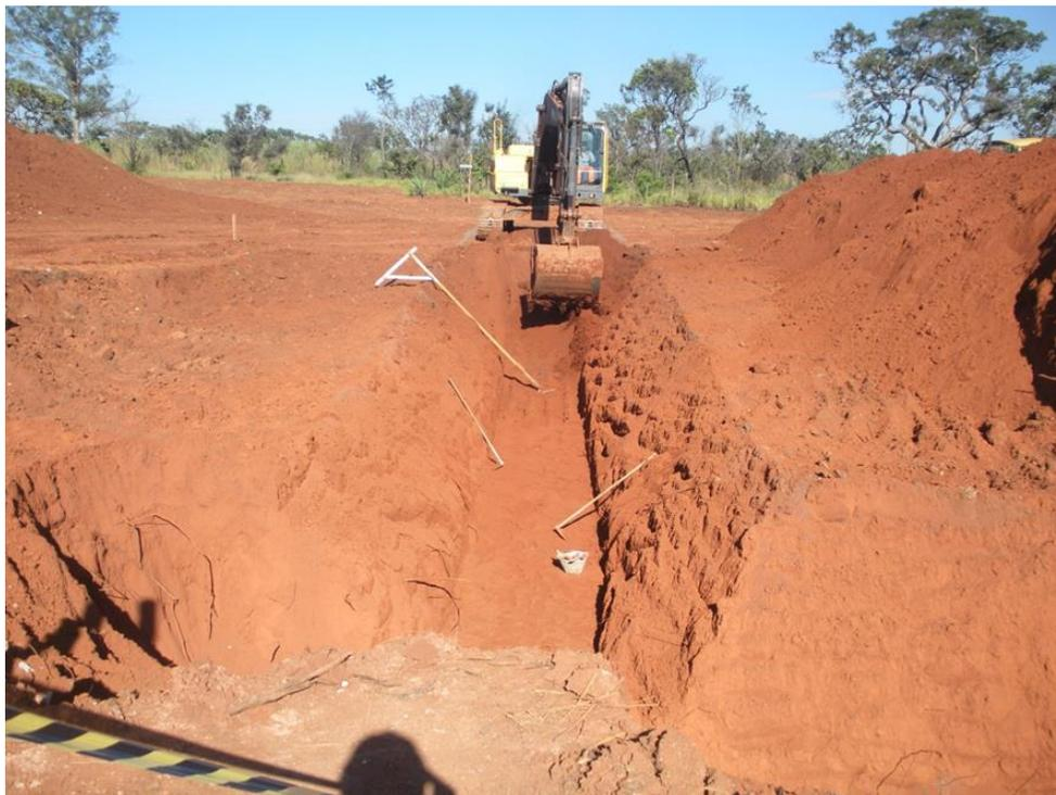
Foto 1 - Escavação mecânica de vala com escavadeira hidráulica com deposição do solo escavado na lateral da vala.
