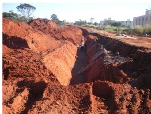
Fotos 7 a 10 – Trechos de valas sem escoramento – Fonte: Relatório fotográfico e outras fotos referentes à Medição n.º 03.
