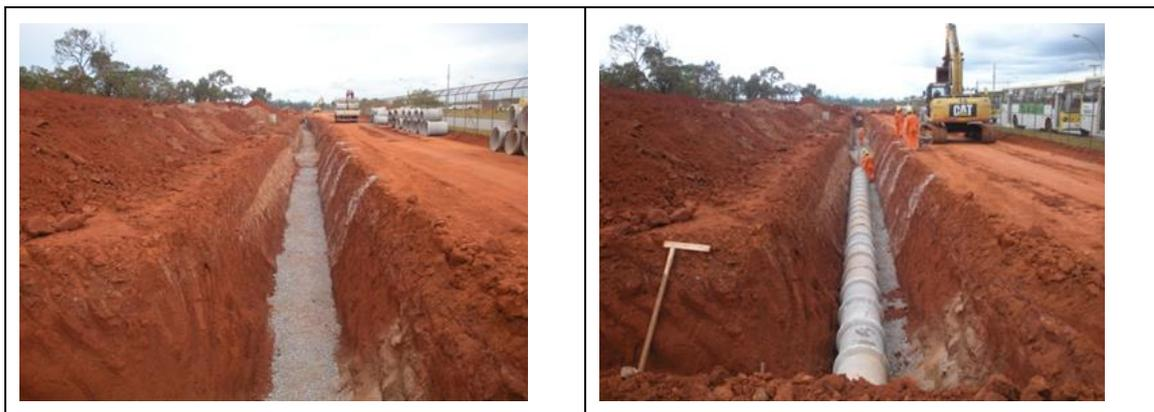
Fotos 11 e 12 – Trechos de valas escavadas sem escoramento e com presença de operários em seu interior. Fonte: Relatório Fotográfico da 4ª Medição.
