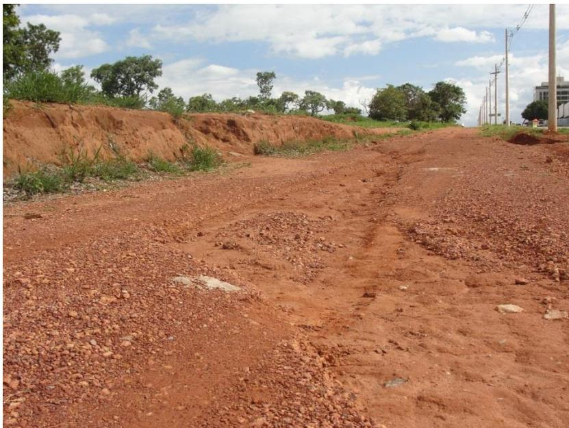
Foto 1 - Trecho da ciclovia: deterioração do material da base (cascalho).
