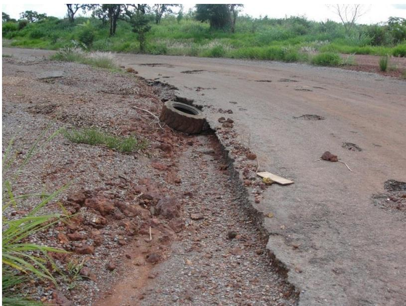
Foto 2 - Deterioração da base das vias
