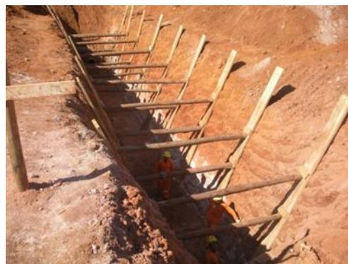
Fotos 5 e 6 – Trecho com valas escoradas – Fonte: Relatório Fotográfico da 3ª Medição.
