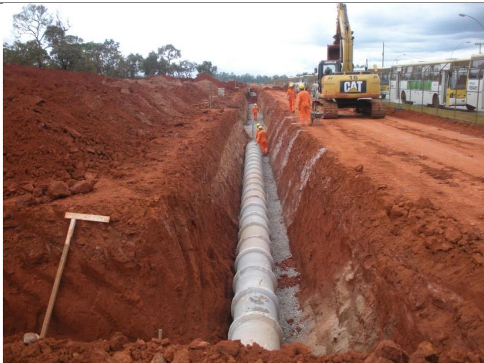
Foto 2 – Visão geral: vala escavada, lastro em pedra britada, tubo assentado e volume de solo escavado ao longo do trecho.
