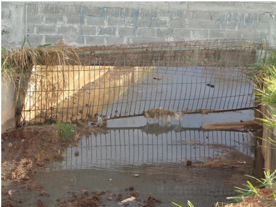
Foto 02 – falha no cercamento na necrópole de Sobradinho.
