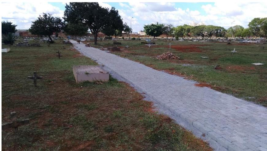
Foto 21 – construção de via pavimentada para passagem de veículo elétrico (que transporta o esquife funerário) no cemitério de Taguatinga.
