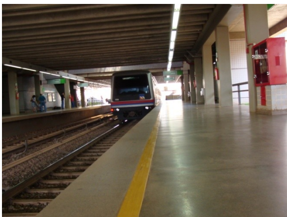
Sem sinalização para PNEs - Estação Concessionárias
