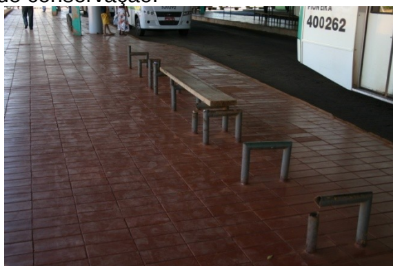
Bancos sem manutenção – Terminal Setor O
