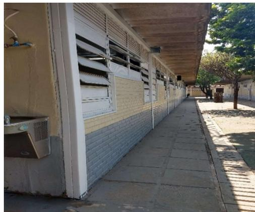
CED 14 de Ceilândia: Janelas basculantes, inadequadas para ventilação
