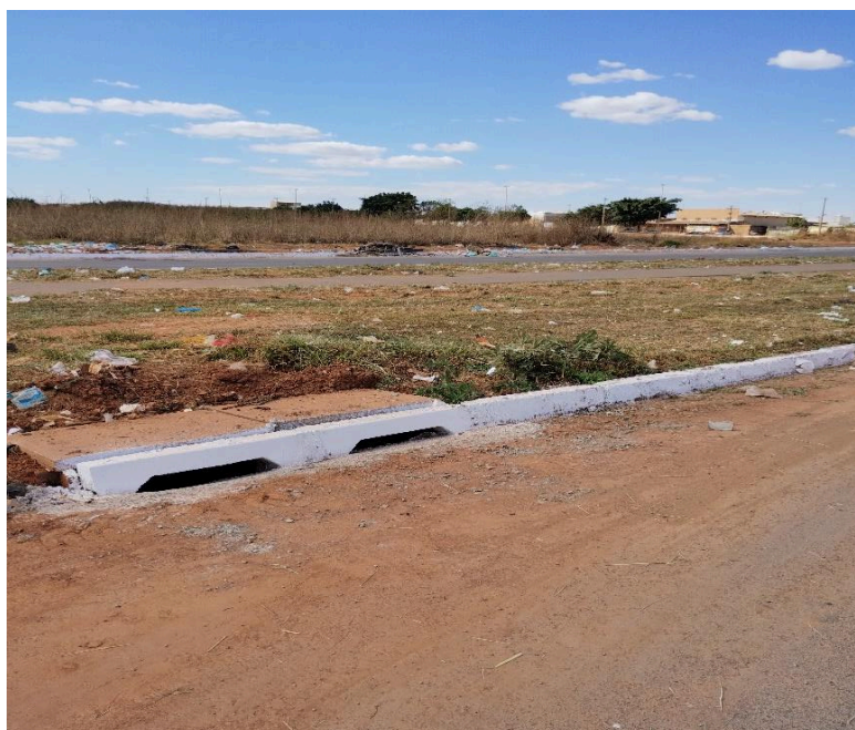
Figura 3: Bocas de lobo.
