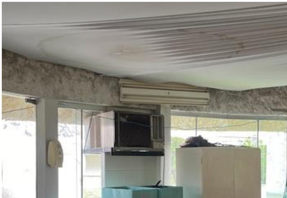
\* Ar-condicionado antigo, fiação exposta, mofo no teto
