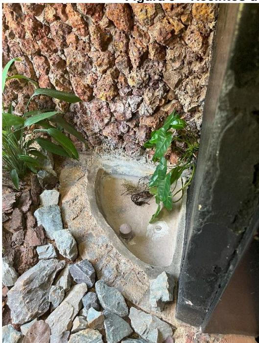
\* Tanque vazio (registrou-se que diversos tanques estão com vazamento e não mantém água por muito tempo)
