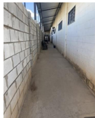
UBS 04 – São Sebastião – entrada da unidade que funciona nos fundos da Agência do Trabalhador
