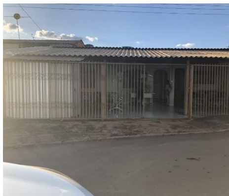
UBS 12 – São Sebastião – fachada da unidade que funciona em casa alugada
